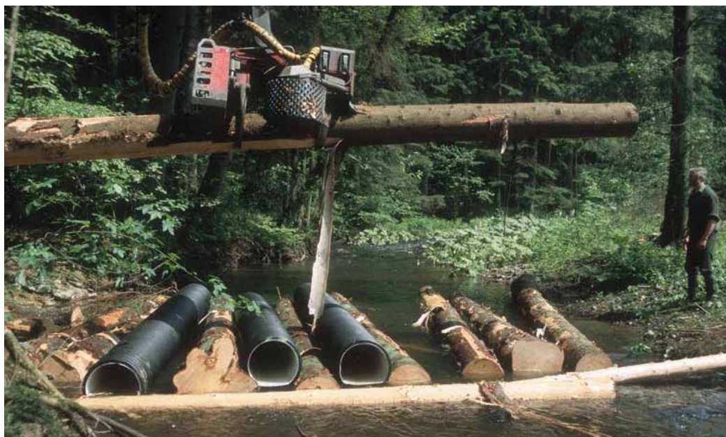
Installation d'un dispositif de traversée temporaire de cours d'eau
