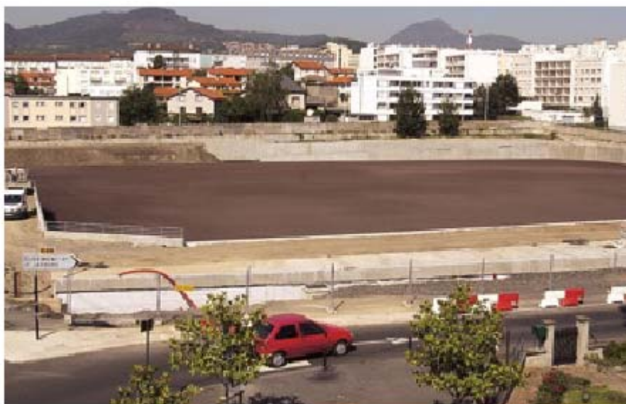
Figure 15 - Terrain de sport adapté pour remplir une fonction de bassin de régulation (Clermont-Ferrand)
