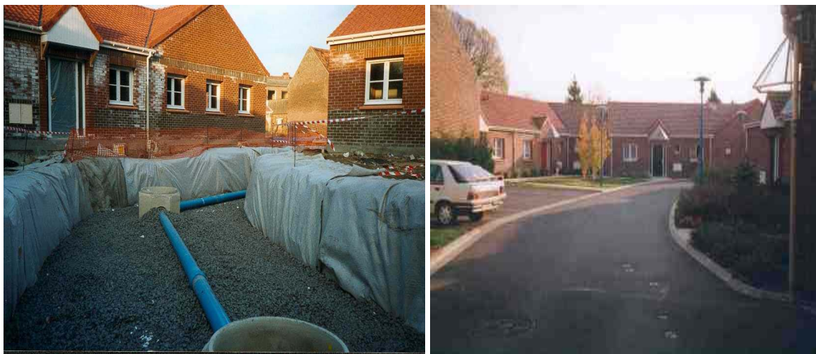
Figure 11 - Tranchée drainante à lambres (France)
