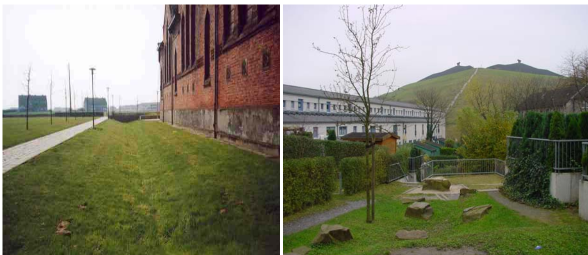
Figure 12 - Exemples de Noues à Douai (France) et Gelsenkirchen (Allemagne)
