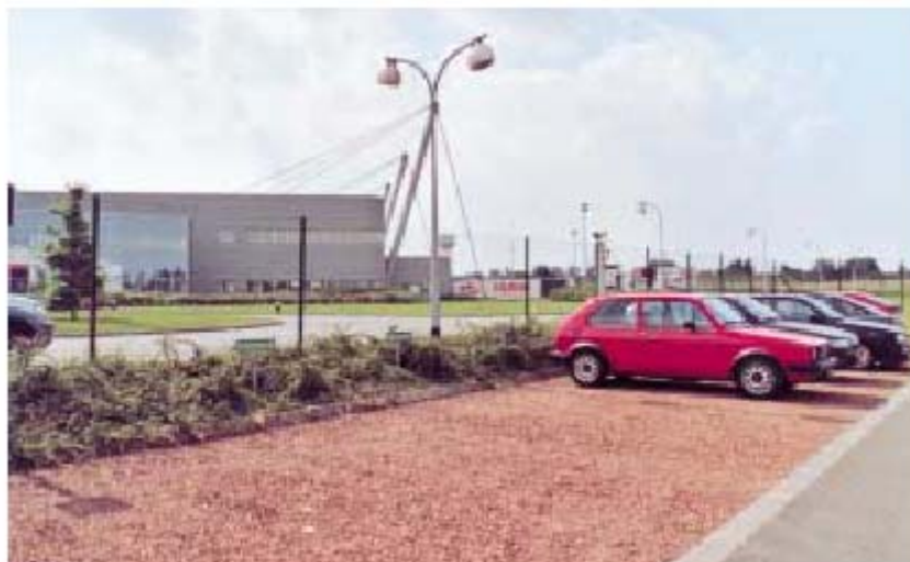
Figure 14 - Parking employant un revêtement perméable (Hem – Suisse)
