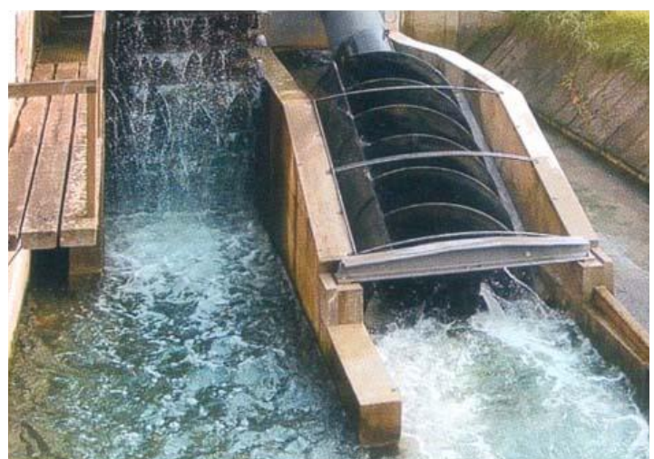
Turbine « fish friendly » en vis d'Archimède © Ritz - Atro
