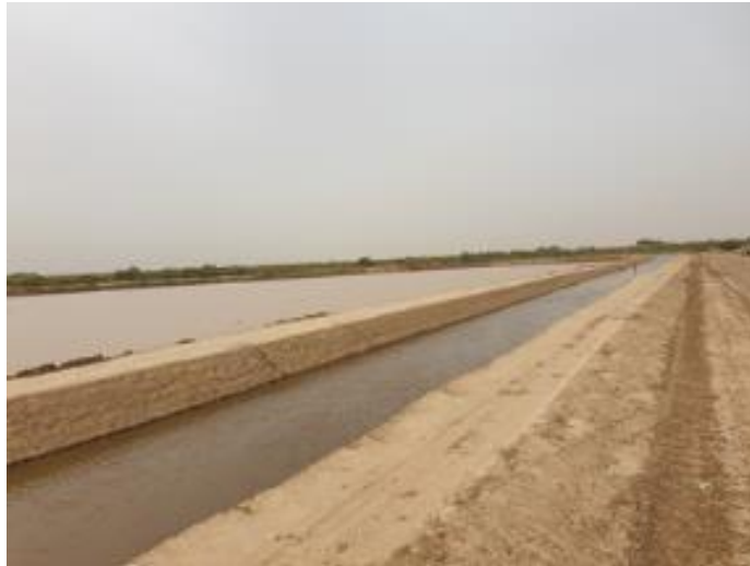
Photo 9 : Vue d'un canal taluté d'une parcelle en cours de lessivage (CSS, 2019)
