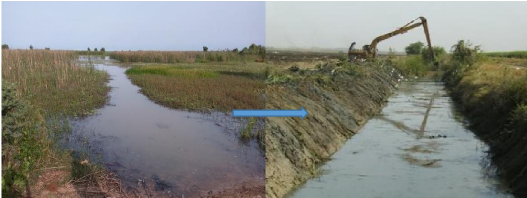
Photo 27 : Enherbement des plans d'eau (a) et (b) curage à la pelle mécanique d'un drain (CSS)
