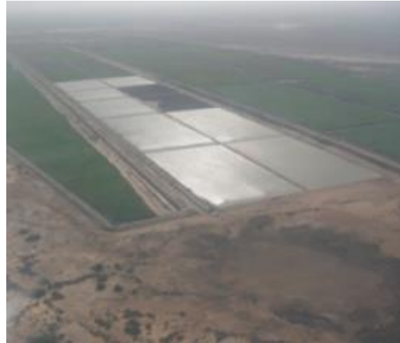
Photo 11 : Mise en eau pour lessivage (CSS)
