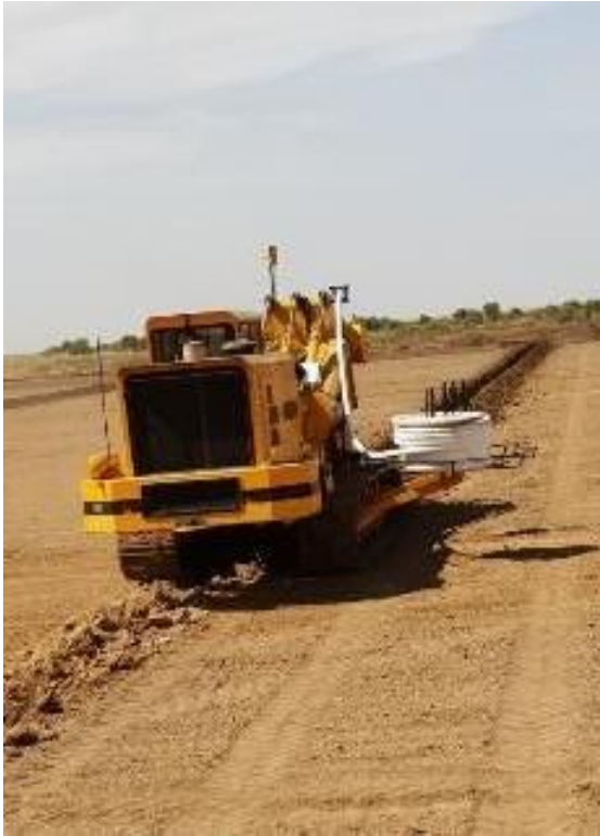
Photo 7 : Draineuse/trancheuse pour installer le drain
