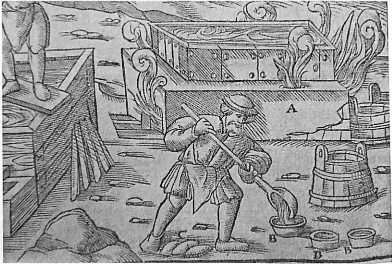
Fig. 6. — Préparation de la couperose au XVI e siècle Réservoirs, chaudrons et perches pour la cristallisation ( G. Agricola, De re metallica , p. 462, Bâle, 1621).
