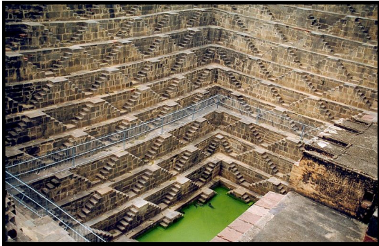
Figure 15: Escaliers à Jaipur, Indes. via le site Wikipédia.
