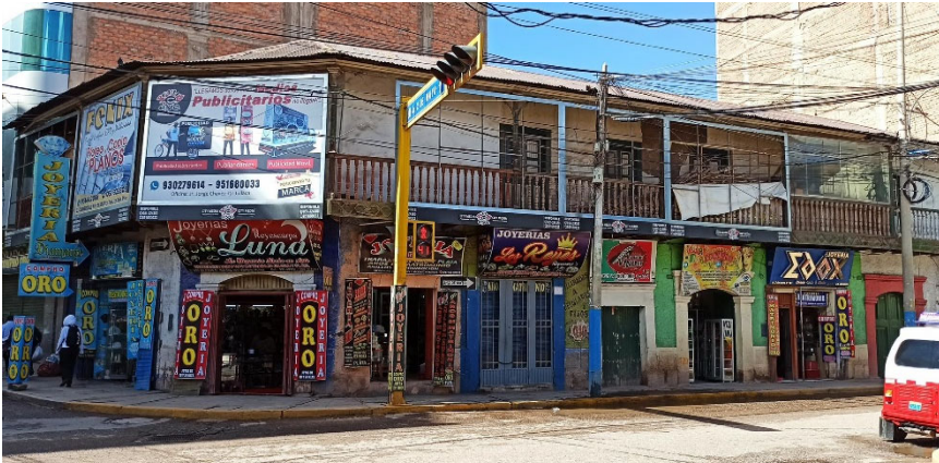
FIGURA 6. Estilo arquitectónico colonial-republicano frente al Centro Comercial N° 2
