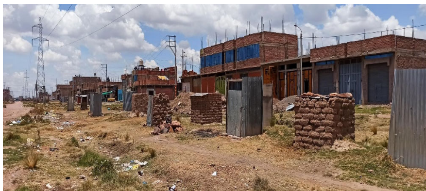
FIGURA 11. Letrinas provisionales (silos) suplen la falta de saneamiento en el área periférica.
