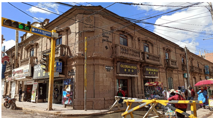
FIGURA 5. Estilo arquitectónico barroco del Pueblo Nuevo en la Plaza Bolognesi.
