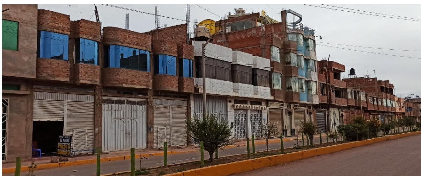
FIGURA 9. Tipología de casa-comercio y edificio-comercio en la Avda. Tambopata
