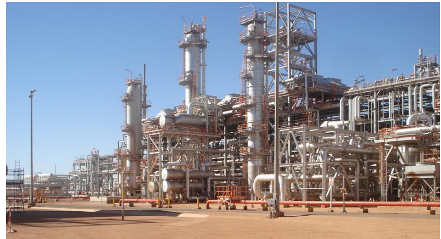
Algérie, 2017. Adoucissement du gaz naturel Echelle: 1400-2800 tonnes par jour CO 2
