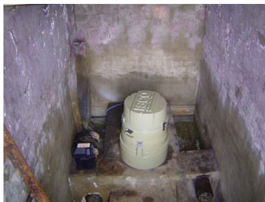
Photo 3. Dispositif d'échantillonnage dans la galerie G6
