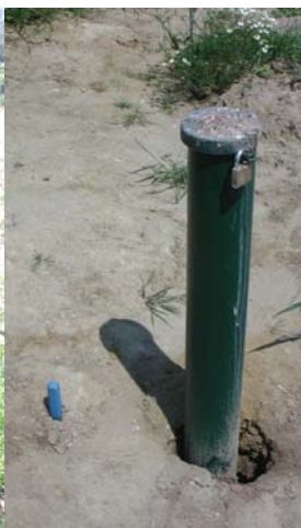
Photo 7. Vue de la partie supérieure de la sonde à humidité après installation
