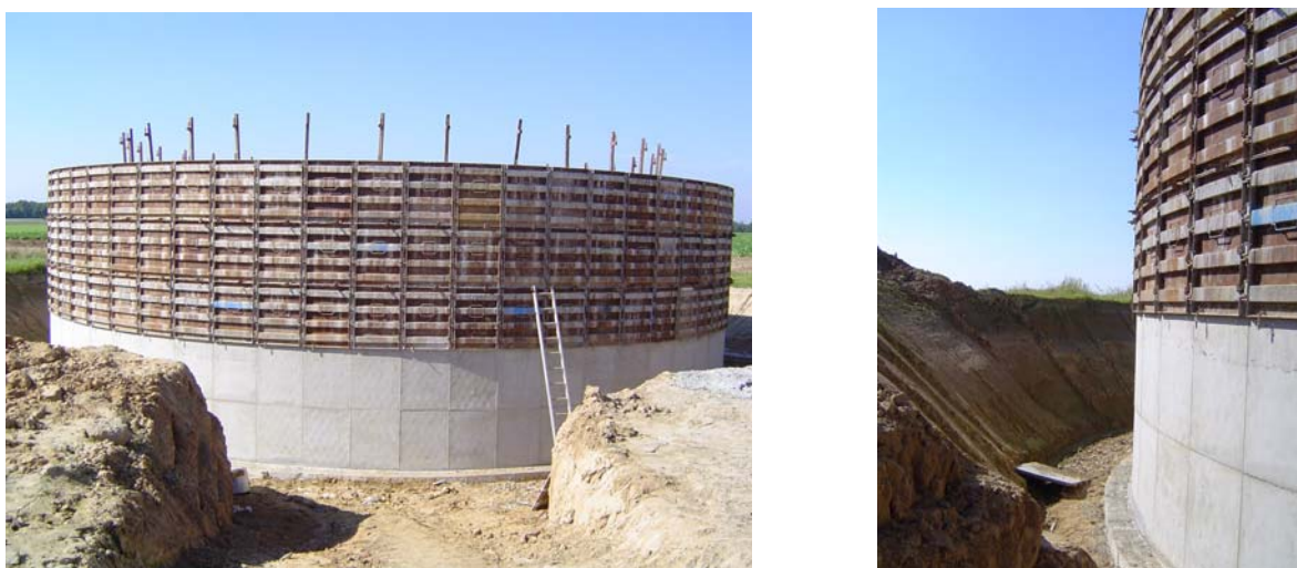
Photo 3. Réalisation d'une citerne hors sol de 1000 m 3 dans le cadre de la mise aux normes
