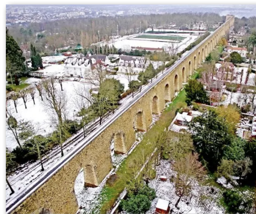
L'aqueduc de Louveciennes 36 arches, 643 m de long, 2 à 4,4 m de large, 10 à 20 m de hauteur
