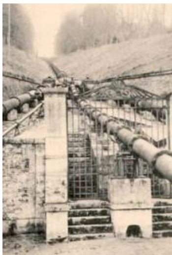
Bougival – les conduites d'eau
