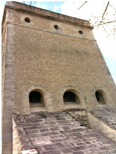
L'accès à la tour du Levant
