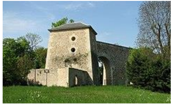
La tour du Jongleur, à l'extrémité méridionale Est d'où partait un siphon vers les bassins de Marly et de Louveciennes
