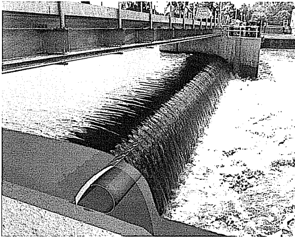
Figure 4 : Vanne gonflable à volet métallique
