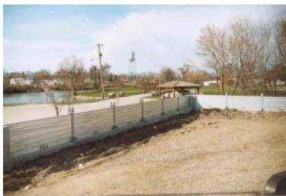
Figure 34 : Batardeau à poutrelles 1
