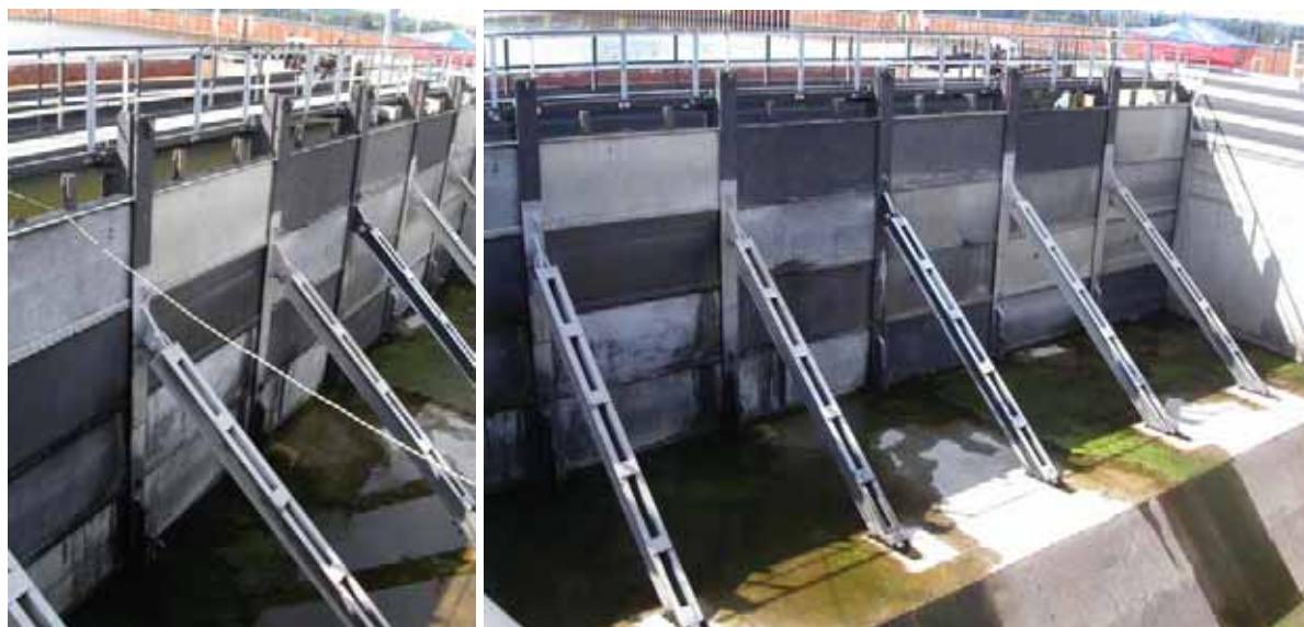
Figure 29 : Photos des batardeaux de Magdeburg (Allemagne)
