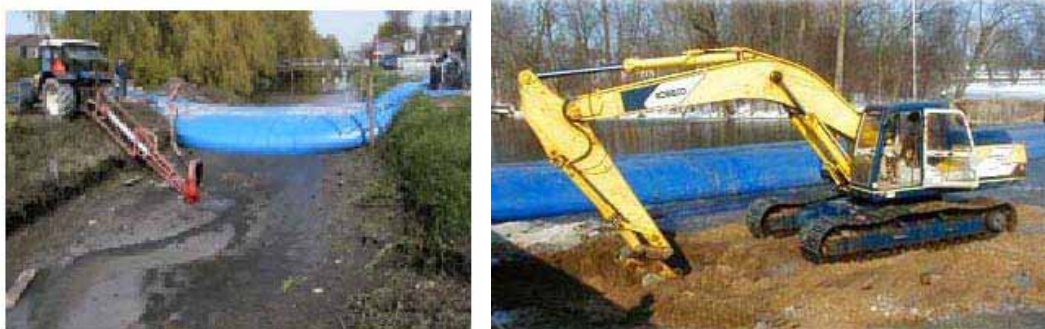
Figure 53 : Installation d'un batardeau AquaTube
