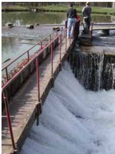
Figure 11 : Problème de non-étanchéité de bouchure à aiguilles augmenté par la vétusté des systèmes 1
