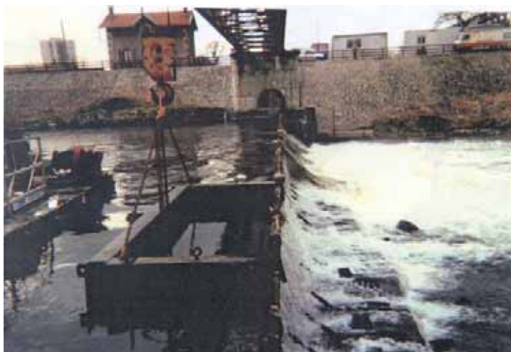
Figure 74 : Mise en place d'un batardeau ventouse à Roanne
