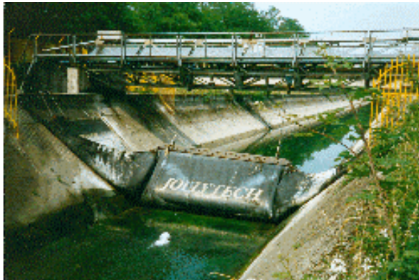
Figure 4 : Batardeau voile en service et mise en place 1
