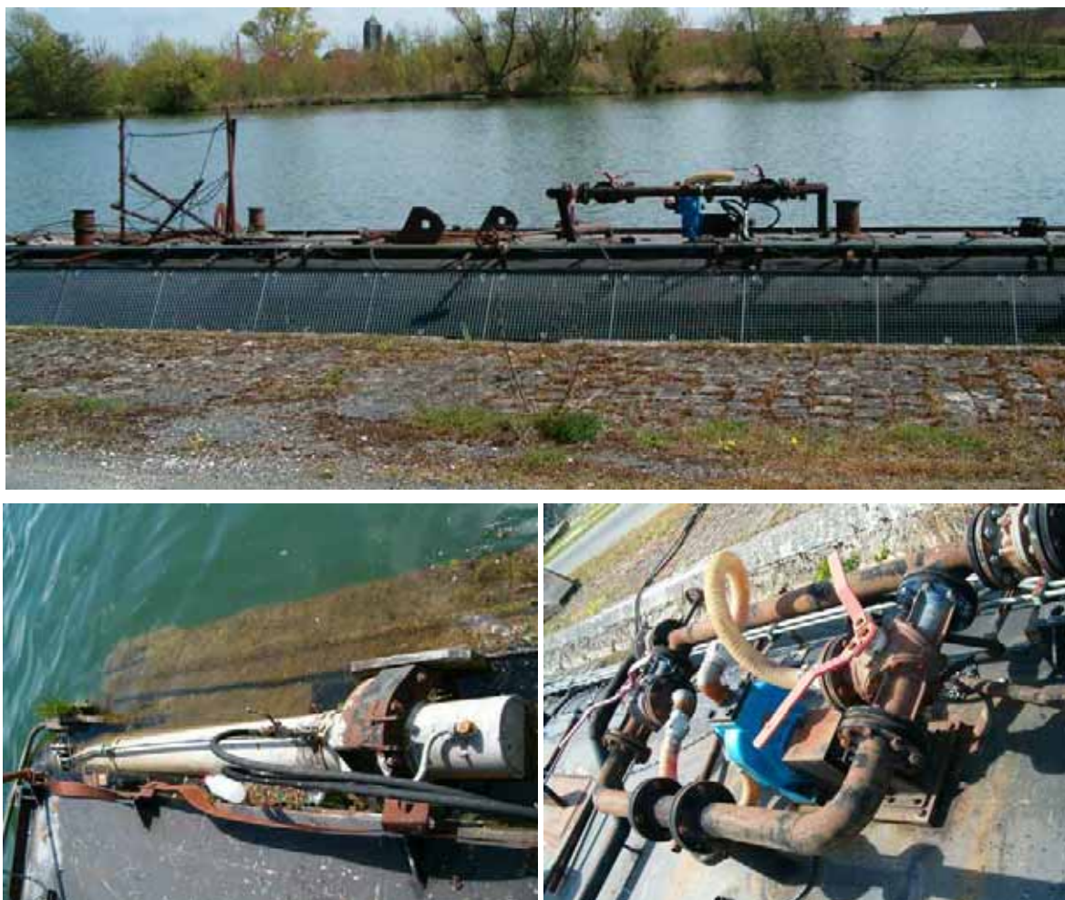
Figure 43 : Équipements du batardeau flottant
