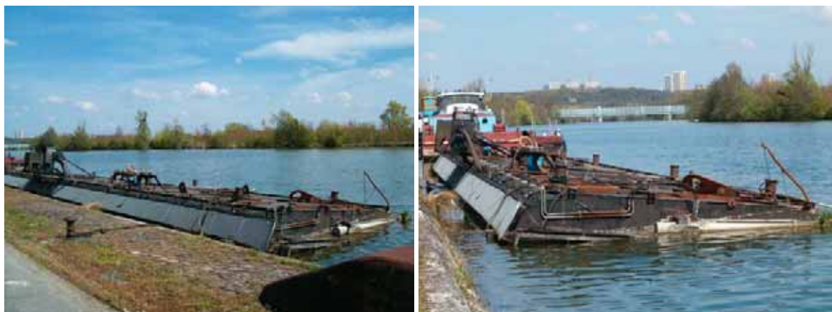
Figure 39 : Batardeau flottant de la Seine Amont
