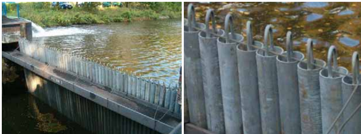
Figure 7 : Aiguilles à section ronde
