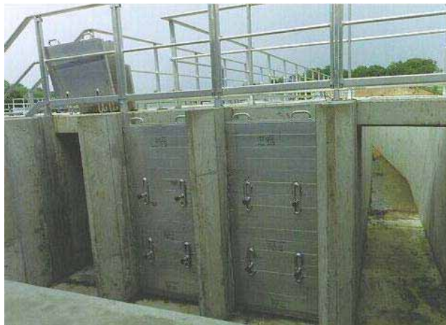
Figure 32 : Batardeau en plaques d'aluminium
