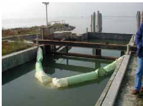
Figure 5 Batardeau voile à élément flottant 5
