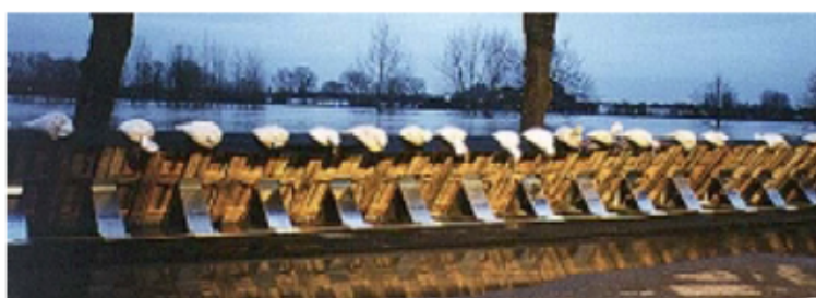
Figure 63 : Batardeau avec palettes et supports métalliques
