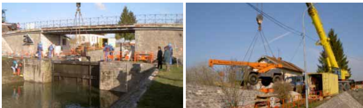
Figure 18 : Moyens importants (hommes et machines) pour l'utilisation du batardeau 1
