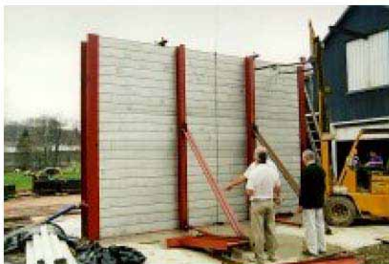
Figure 34 : Batardeau à poutrelles 1
