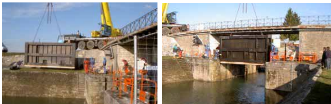
Figure 17 : Installation du batardeau modulaire 2
