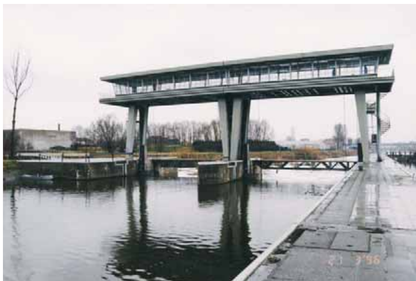
Figure 15 : Batardeau-passerelle (barrage de Menen, Belgique) 1
