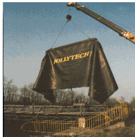
Figure 4 : Batardeau voile en service et mise en place 1
