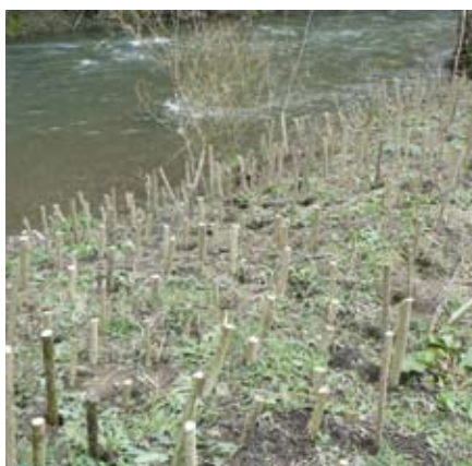
Photos 9, 10 et 11: Evolution d'un site géré par 1) la plantation de plançons de saule, après mise en place du dispositif (à gauche) et 2) la création d'un tapis de saule, après mise en place du dispositif (au centre), après deux années de végétation (à droite).
