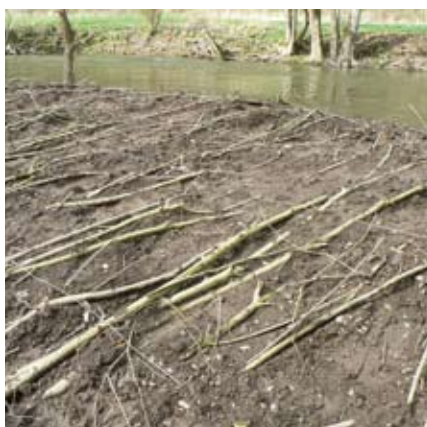
Photos 9, 10 et 11: Evolution d'un site géré par 1) la plantation de plançons de saule, après mise en place du dispositif (à gauche) et 2) la création d'un tapis de saule, après mise en place du dispositif (au centre), après deux années de végétation (à droite).
