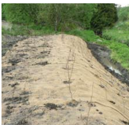
Photos 6, 7 et 8: Evolution d'un site géré par la plantation de plants à racines nues d' Alnus glutinosa ( S_2R_2 ) sur berge talutée et structurée par une natte de coco: état initial (à gauche), après mise en place du dispositif (au centre), après plus d'une saison de végétation (à droite).
