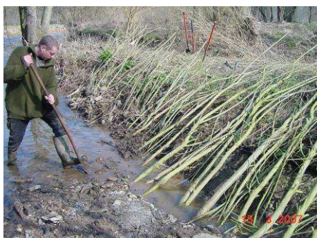
Photo 49. Perches mise en contact avec l'eau.
