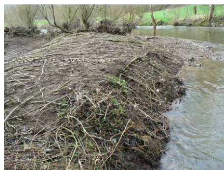
Photo 54. Tapis vivant de saule, réalisé sur berge, après talutage.
