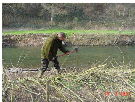
Photo 50. Placement des pieux en damier.
