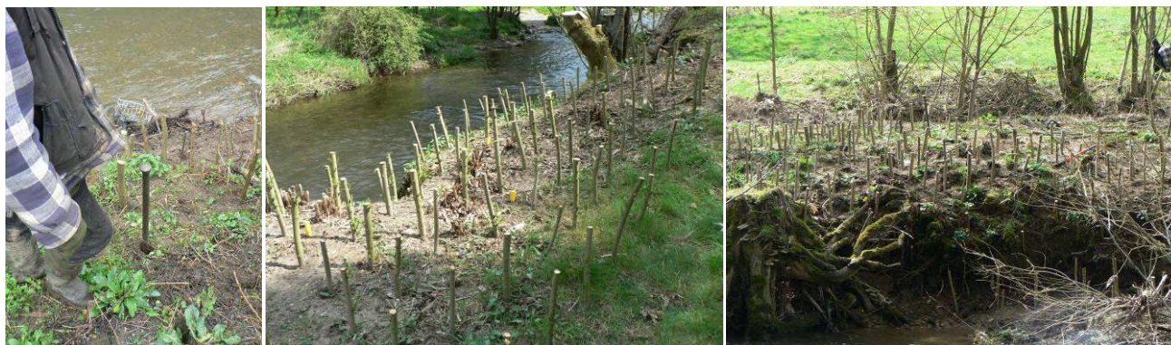
Photos 44 - 46. Plantation de boutures de saules à l'aide d'une barre à mine, selon une densité de 4 – 5 boutures /m 2
