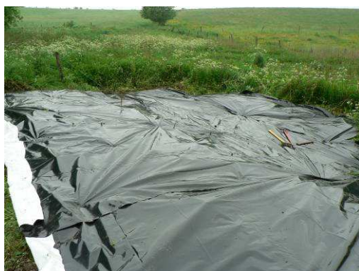
Photos 60 - 61. Positionnement d'une bâche agricole (gauche) ou d'une nappe de paillage (droite). Fixation du pourtour de la bâche dans une tranchée de 15 cm de profondeur à l'aide d'agrafes de fixation. Superposition des bandes successives.
