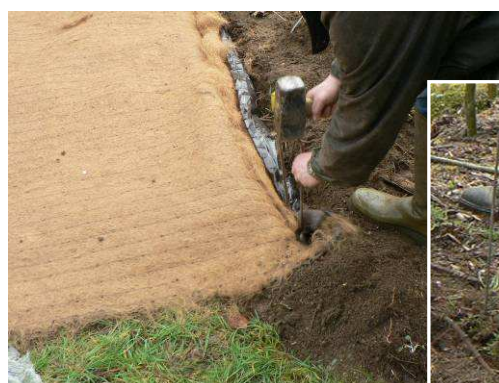
Photos 60 - 61. Positionnement d'une bâche agricole (gauche) ou d'une nappe de paillage (droite). Fixation du pourtour de la bâche dans une tranchée de 15 cm de profondeur à l'aide d'agrafes de fixation. Superposition des bandes successives.
