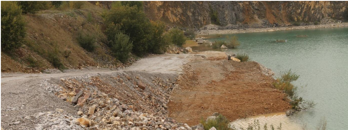
Berge en pente douce sur une ancienne fosse en cours d'ajustement en 2020.
