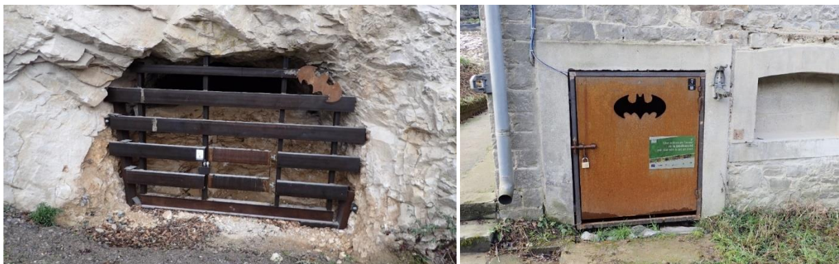
Fermeture d'une ancienne galerie d'exploitation à l'aide de barreaux métalliques et sécurisation de caves sous bâtiments (© Julien Taymans)
