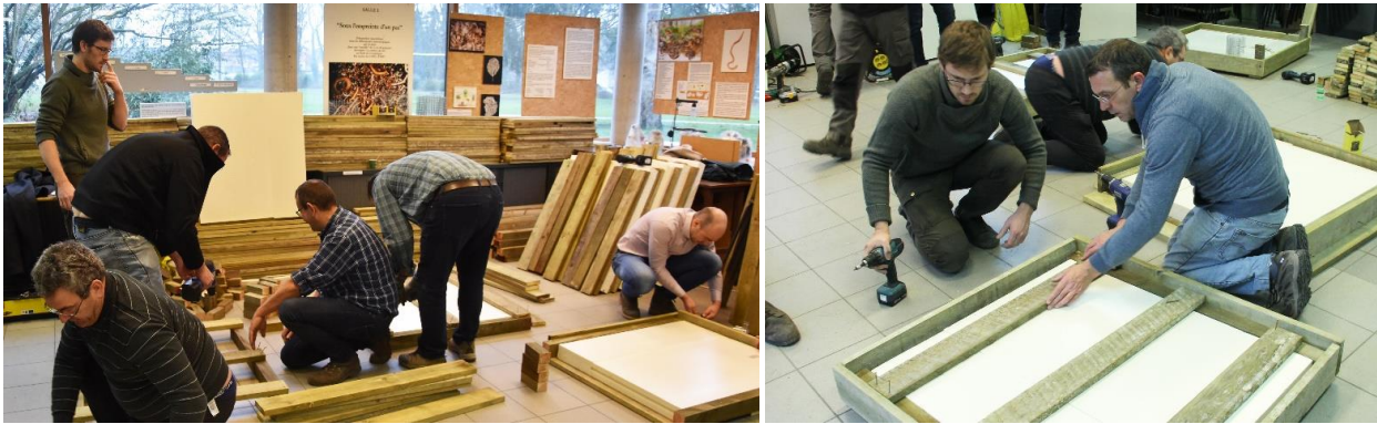
Séance de construction des plateformes à Goéland cendré.
