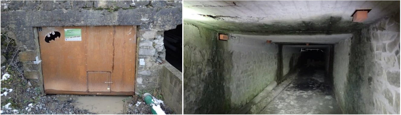
Sécurisation d'une galerie technique et intérieur équipé de micro-gîtes du type « briques creuses » sur panneau marin (© Julien Taymans).
