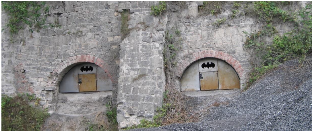
Fermeture d'un four à chaux.
