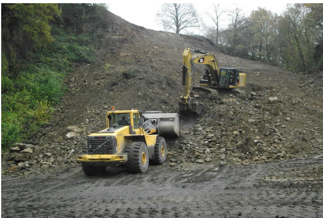
Fig. 3 - L'attaque du chantier.
