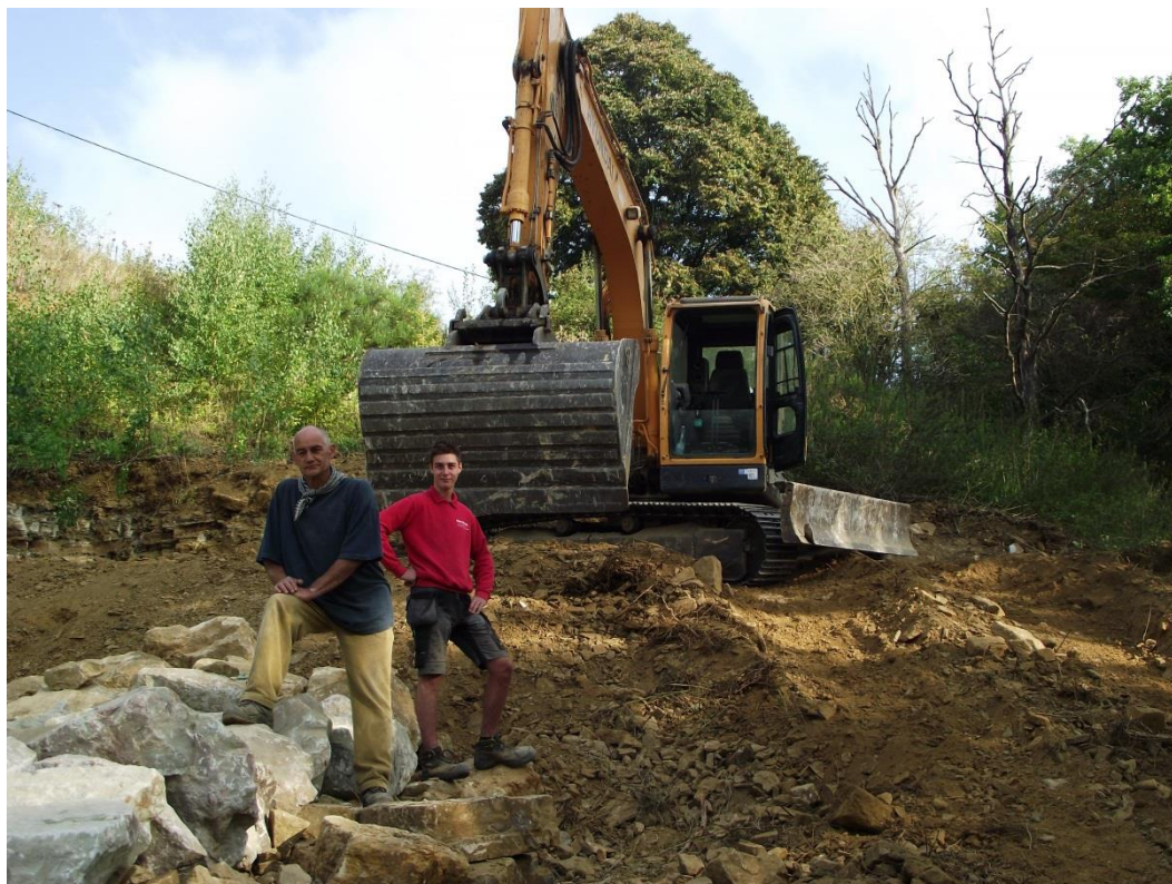
Fig. 16 - Paolo, responsable du chantier, et Hugo, machiniste.
