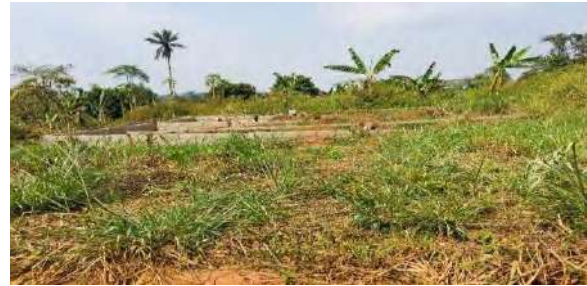
Photo 1 Chantier sur les espaces agricoles
