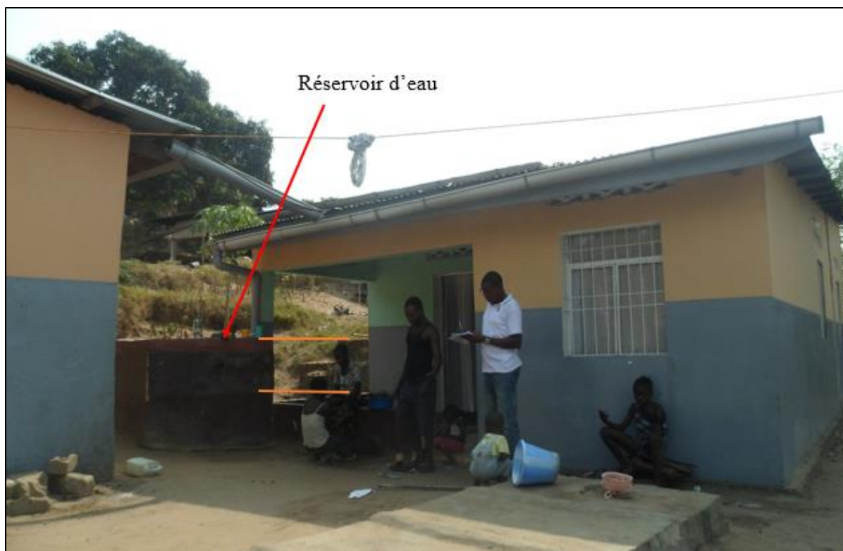
Figure 10.1.1a : Sur l'avenue Kabongo, un propriétaire de la parcelle a été obligé d'augmenter la capacité de stockage de son réservoir d'eau, en rajoutant et construisant quelques rangées des blocs. Figure réalisée par l'auteur sur une photographie réalisée en 2018.
