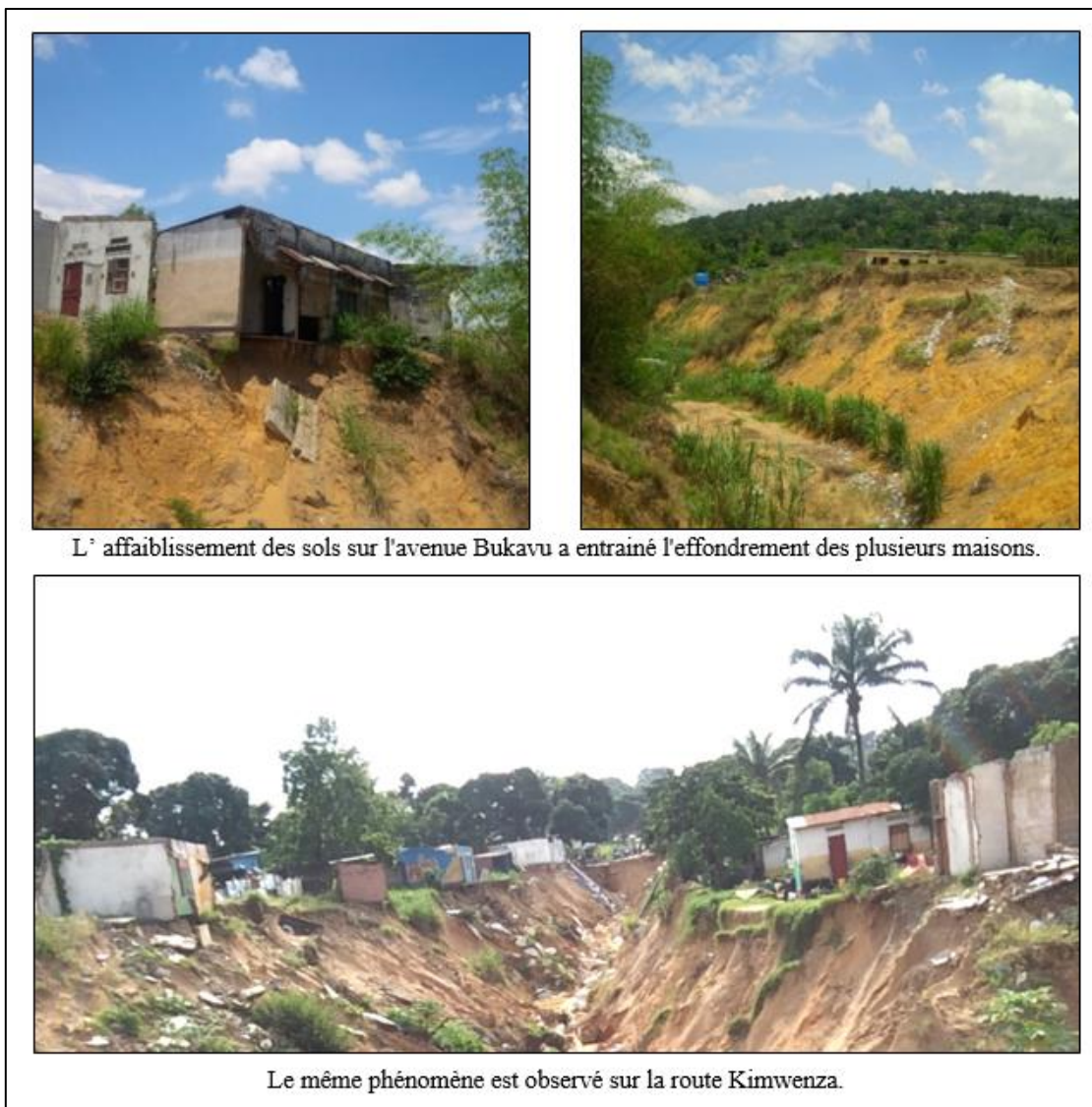
Planche 3.4.1 : Les rues disposées perpendiculairement aux courbes de niveau en proie des érosions ravinante à KINDELE. Photographies réalisées par l'auteur en 2018
