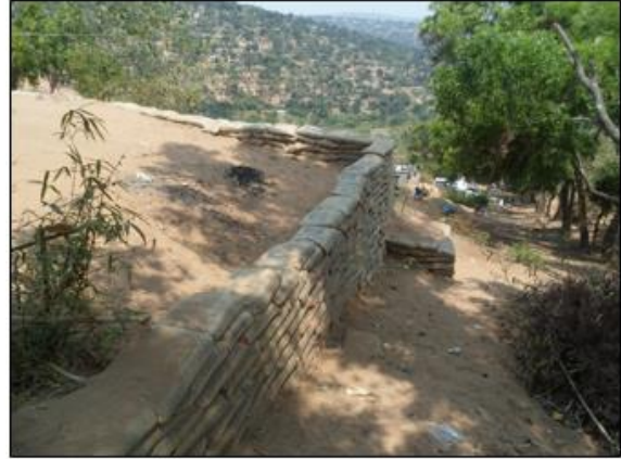
Murs de soutènement en sacs remplis des terres (joints décalés d'assise en assise)
