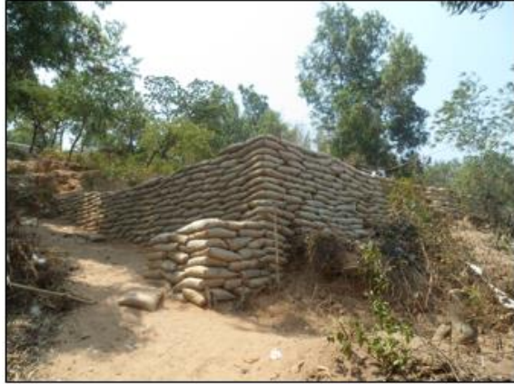
Murs de soutènement en sacs remplis des terres (joints décalés d'assise en assise)
