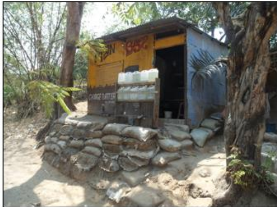
Les paspalums plantés entre les joints assurent une bonne protection des sacs contre l'ensoleillement (cause principale de dégradation de ces sacs).
