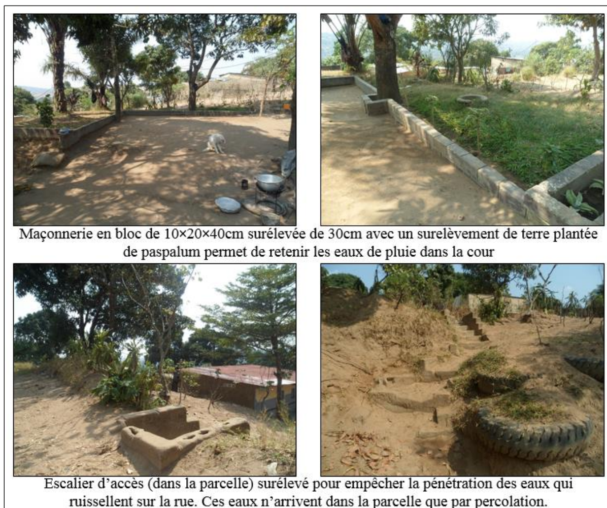
Planche 7.2.4b : Dispositif de lutte antiérosive mis en place : matériaux de récupération (pneus), maçonnerie en bloc de 10×20×40cm surélevée de 30cm avec un surelèvement de terre plantée de paspalum, etc.
