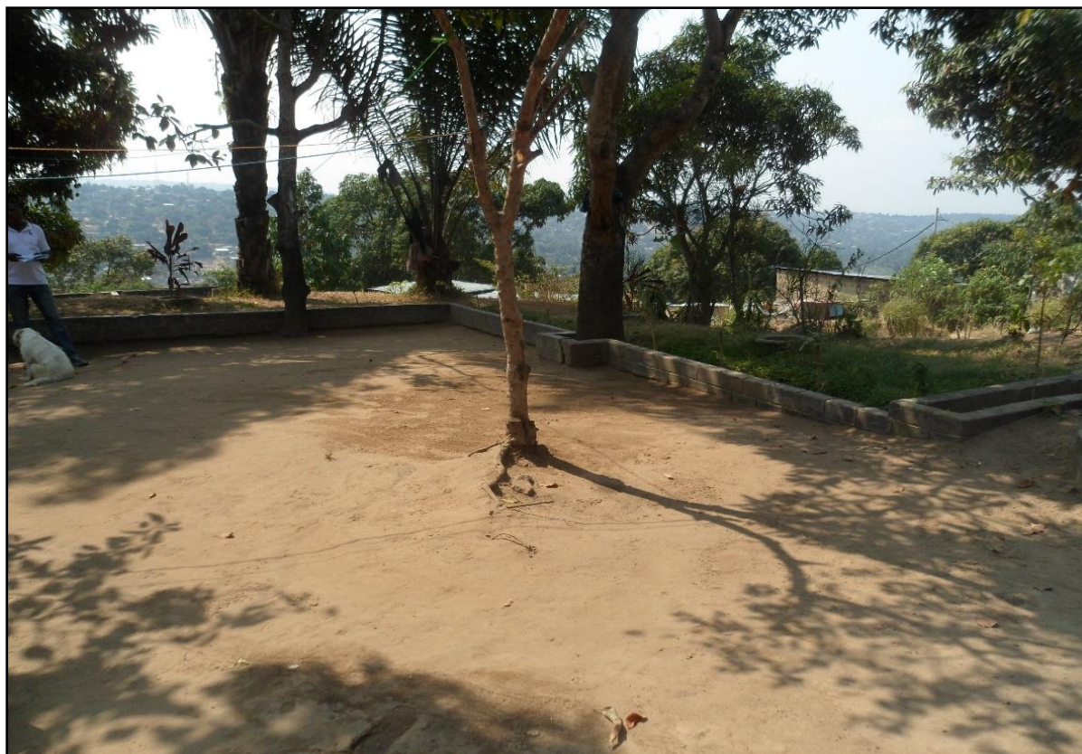
Photo 10.1.1c : Bordure en maçonnerie en bloc de 10×20×40cm surélevée de 30cm avec un surelèvement de terre planté de paspalum. Photographie réalisée par l'auteur en 2018.
