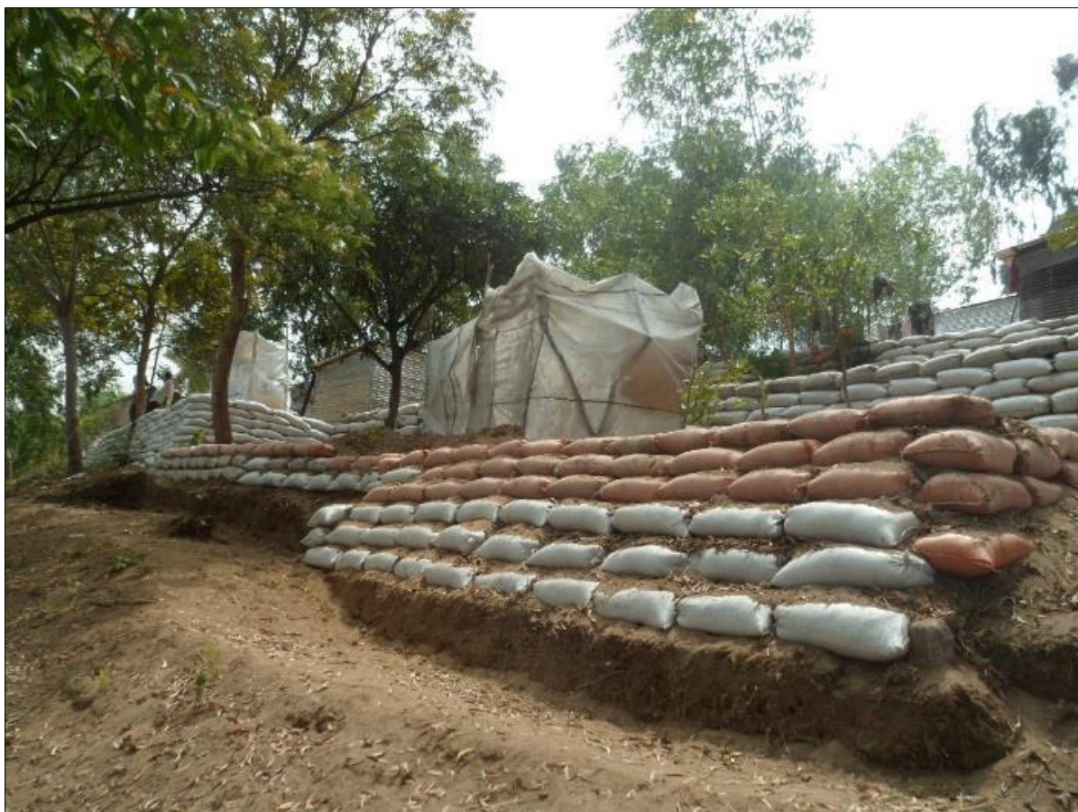
Photo 11.4 : Rue implantée suivant le niveau établi par une courbe de niveau à KINDELE, avec un talus soutenu par des sacs remplis de terre. Photographie réalisée par l'auteur en 2018.
