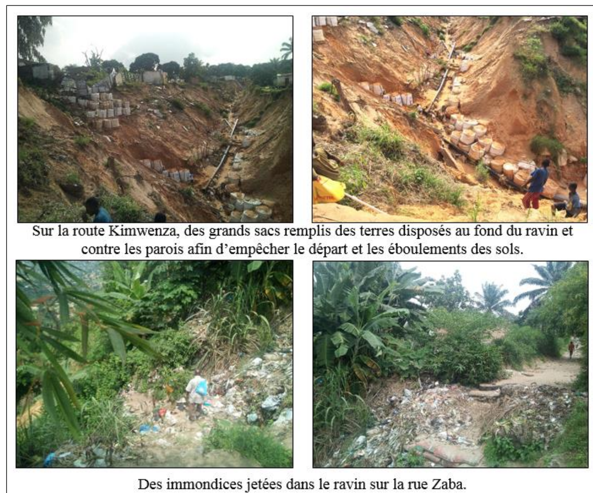
Planche 7.3d : Lutte antiérosive au niveau des ravins
