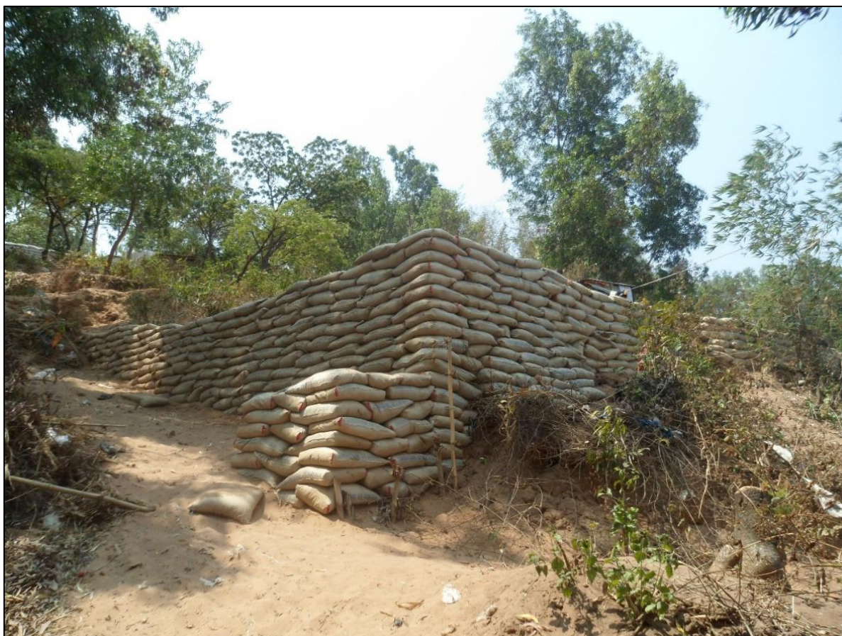
Photo 10.1.1a : Construction d'un mur de soutènement de talus en sacs du polypropylène remplis de terre, avenue 4 Km à KINDELE. Photographie réalisée par l'auteur en 2017.
