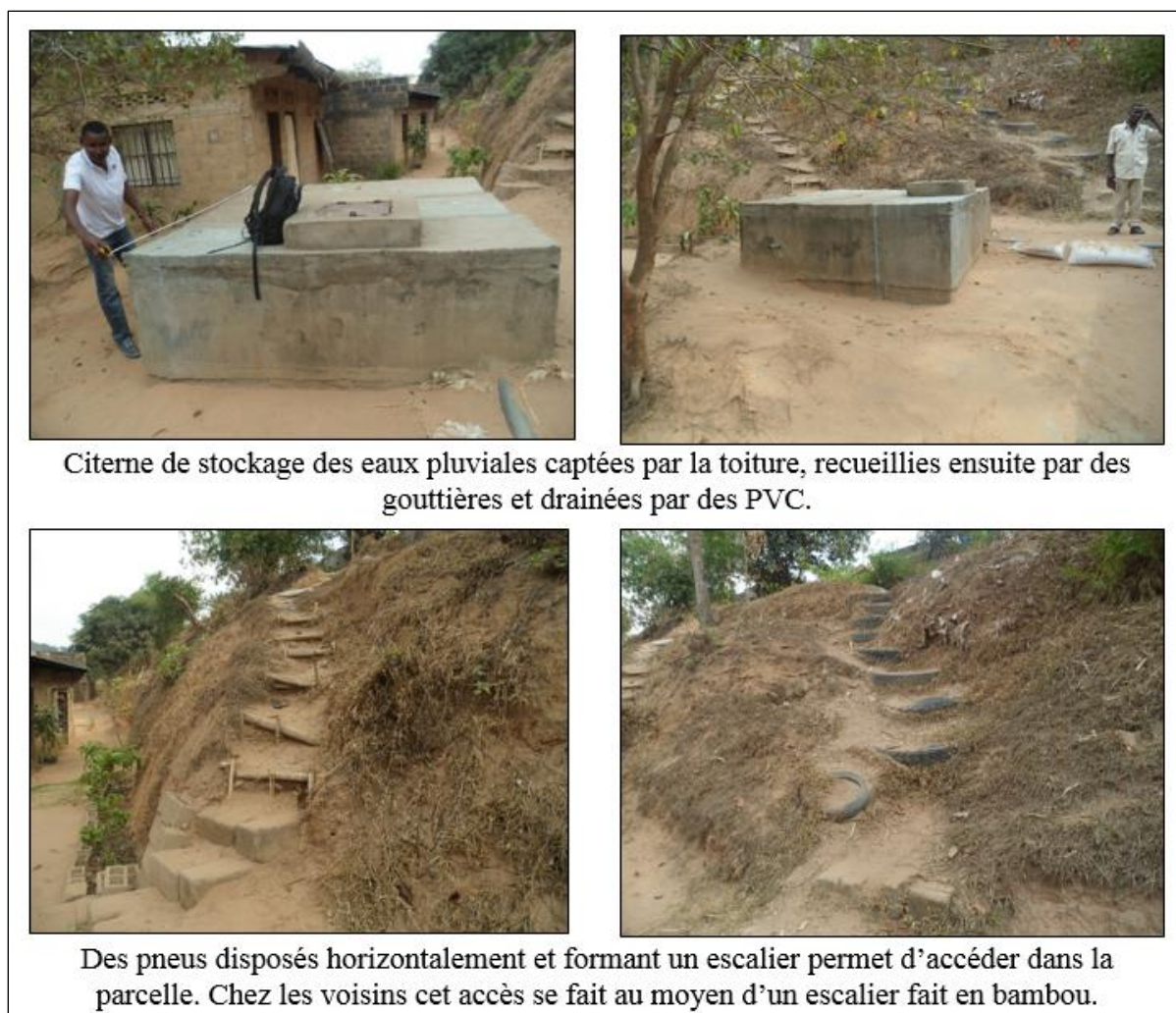
Planche 7.2.4d : Dispositif de lutte antiérosive mis en place : matériaux de récupération (pneus) combinés avec le paspalum, récupération et valorisation des eaux pluviales, etc.
