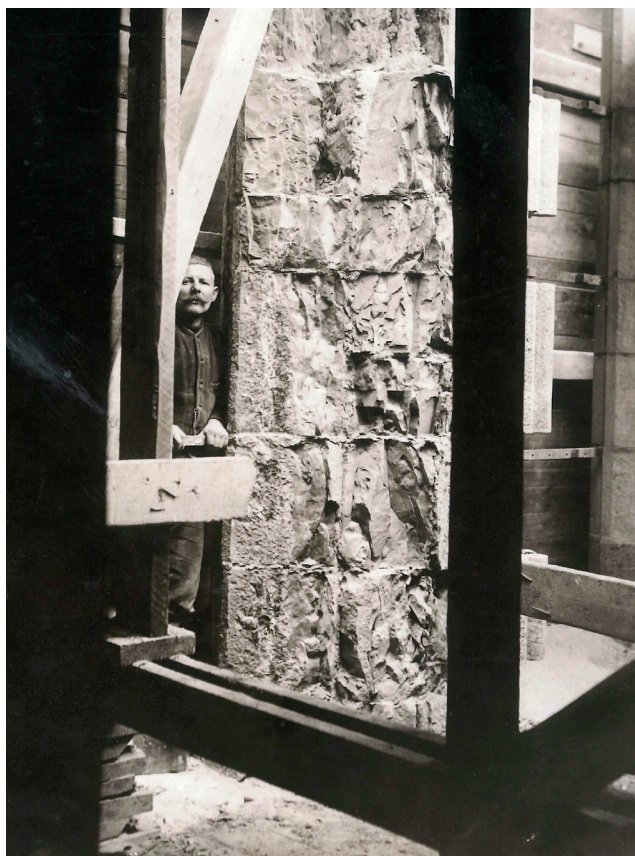
Fig. 41-42.- Détails de l'échafaudage de la restauration de l'église Notre-Dame à Dinant après la Première Guerre mondiale. © Liège, Centre d'Archives et de Documentation de la C.R.M.S.F., fonds de la C.R.M.S.F., dossier « Dinant 1.1 ».
