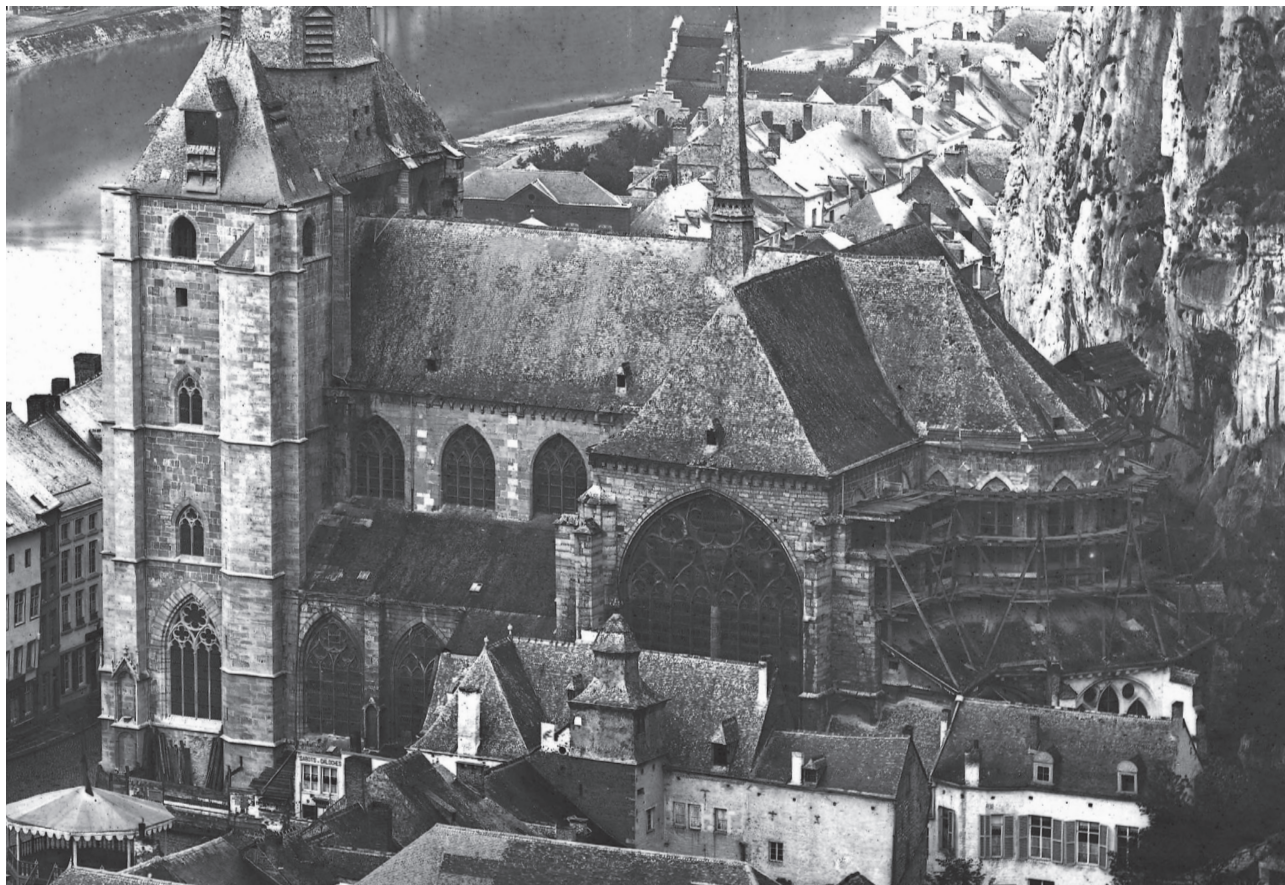
Fig. 18.- Restauration des parties orientales de l'église Notre-Dame à Dinant entre 1876 et 1878.
