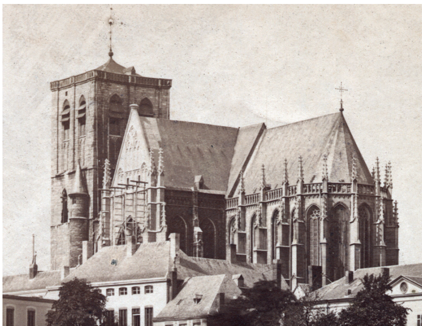
Fig. 7.- Vestiges de l'échafaudage dressé entre 1863 et 1865 contre le mur-pignon sud du transept de l'église Saint-Martin à Liège. Photographie W. Damry. © Musée Wittert ULiège.
