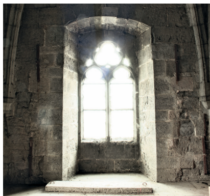
Fig. 17.- Vestiges de l'échafaudage érigé contre la façade de l'église Notre-Dame à Dinant entre 1863 et 1871 : des ancrs boulonnées dans les étages des tours.
