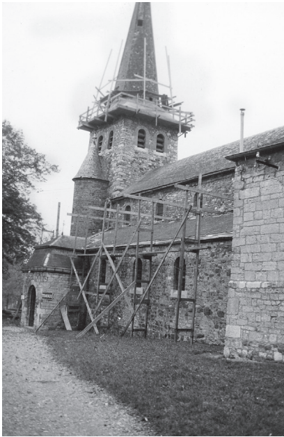
Fig. 27.- Restauration de l'église de Papeleux, 1969. © Province de Liège – Musée de la Vie wallonne, MVW 1101198-001-01.
