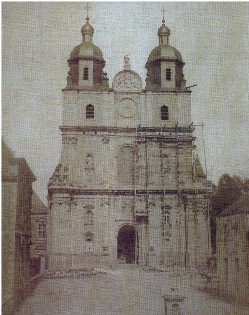
Fig. 1.- Les échafaudages contre la façade de l'ancienne abbatale de Saint-Hubert, vers 1844-1868.
