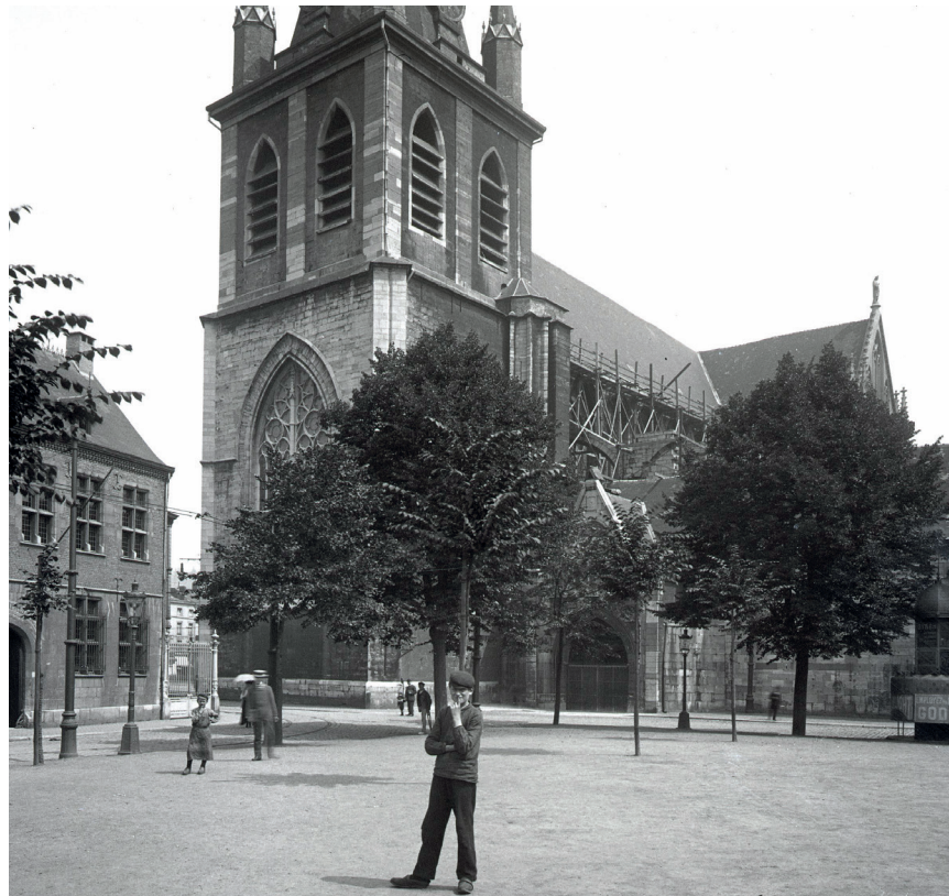
Fig. 37.- Restauration du flanc sud de la cathédrale Saint-Paul à Liège, début du XX e siècle.
