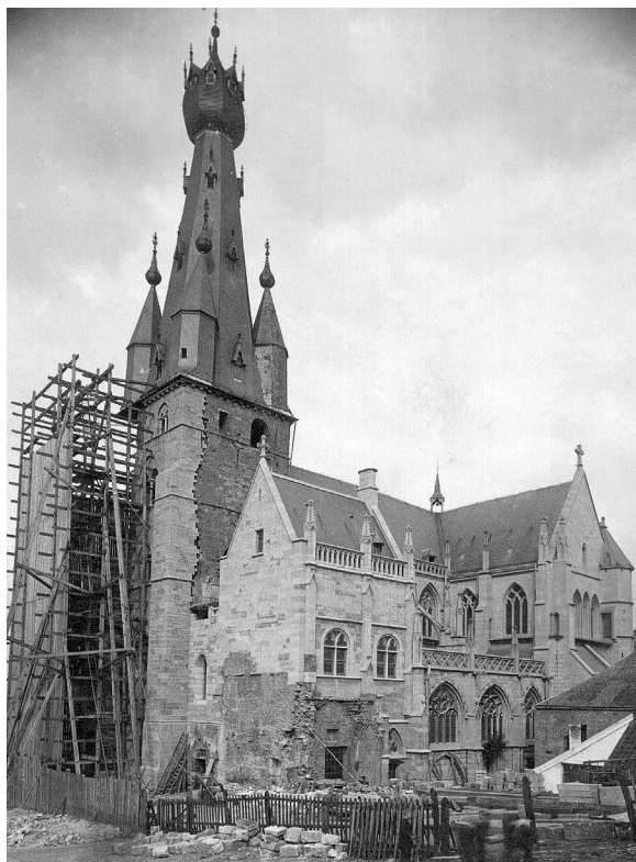
Fig. 9.- Restauration de la tour de l'église Notre-Dame à Walcourt, dernière décennie du XIX e siècle. © IRPA-KIK, Bruxelles.
