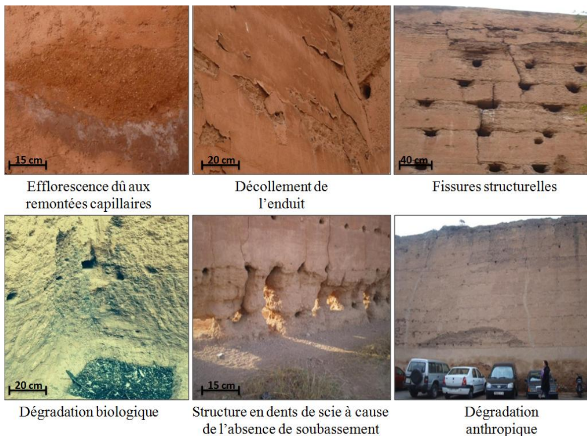
Fig. II.1. Aspects de dégradation des murs des monuments historiques Saadiens dans la région de Marrakech (photos prises au palais El Badi et tombeaux Saadiens en 2016).
