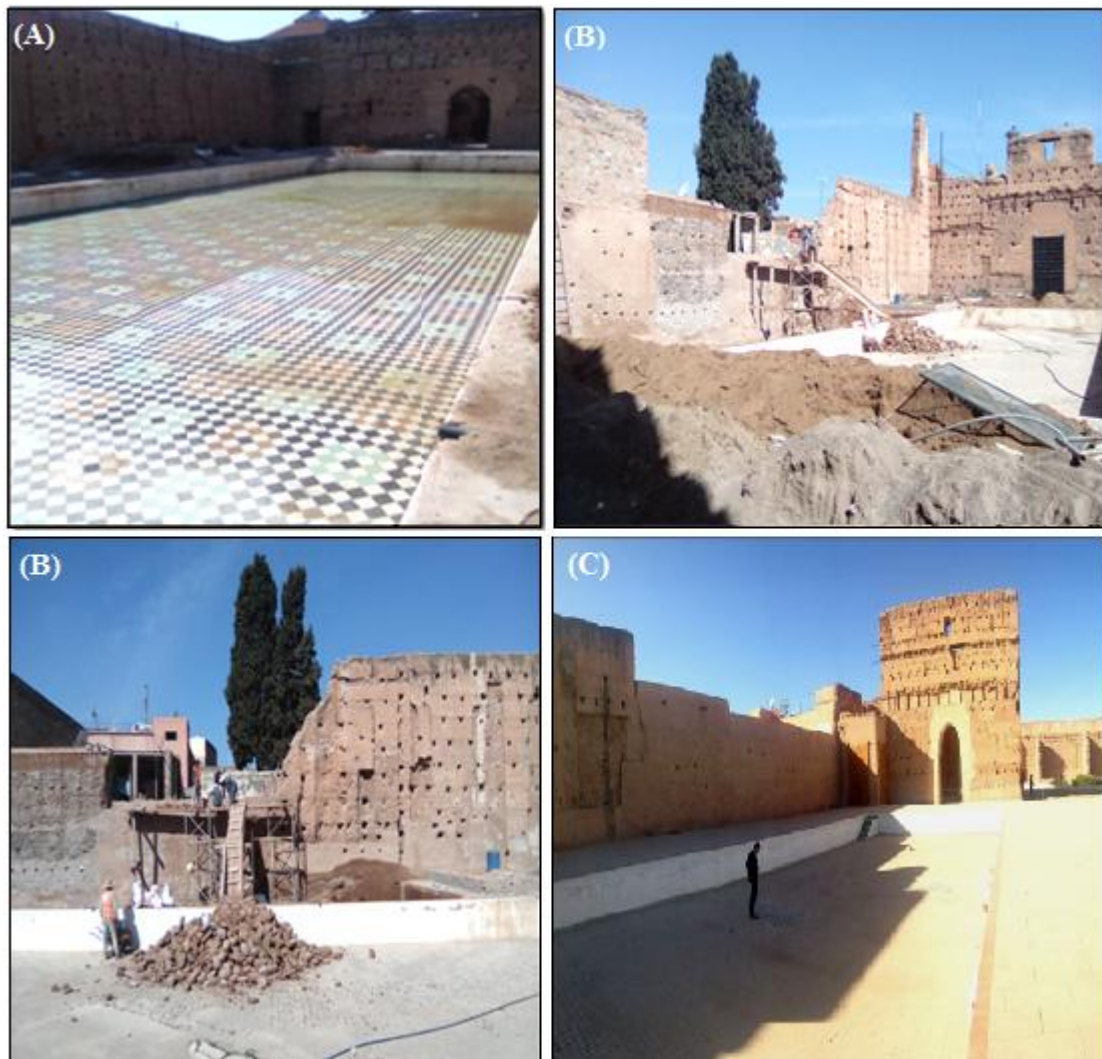
Fig. II.7. (A) Zellige des bassins d'irrigation après la restauration en septembre 2016. (B) Travaux de restauration du mur du palais El Badi en septembre 2017. (C) Disparition de la glaçure du zellige des bassins après les travaux de restauration.
