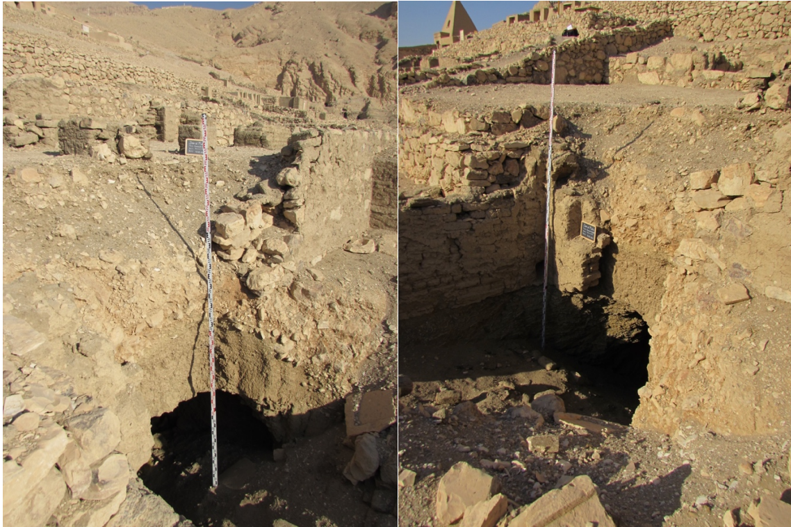
Figure 12. Sols et murs effondrés à l'est des pièces A et B
