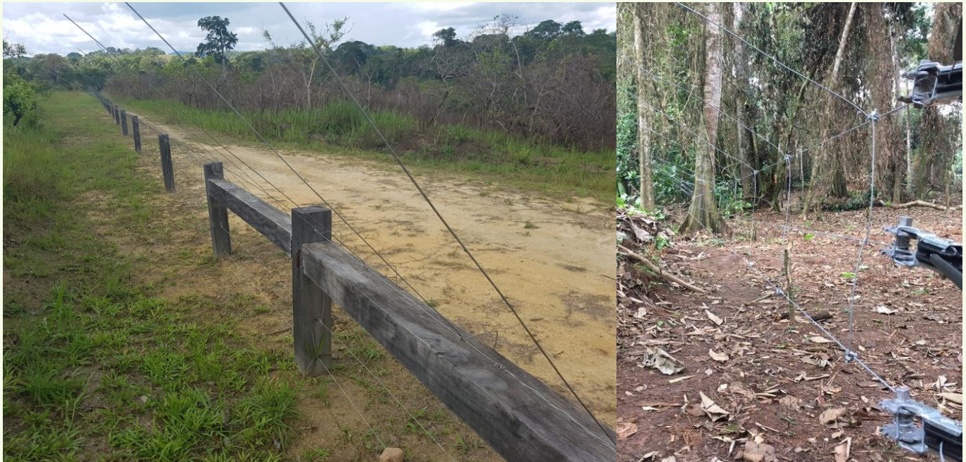
Barrières électriques installées autour des plantations villageoises au Parc National de la Lopé à gauche (crédit photographique : Communication ATR ECOFAC 6) et au Parc National de Nouabalé-Ndoki à droite (crédit photographique : Terry BRNCIC).
