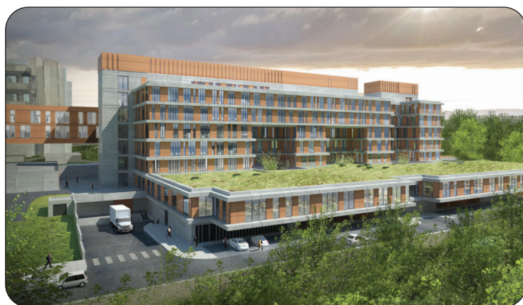
Figure 2. Vues de face et de profil du bâtiment du Centre Intégré d'Oncologie de l'ICAB.
