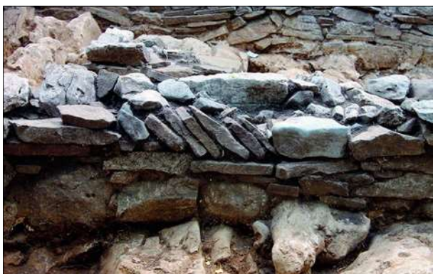
Mur gouttereau nord-ouest du chœur montrant l'utilisation de la technique de construction en opus spicatum .
