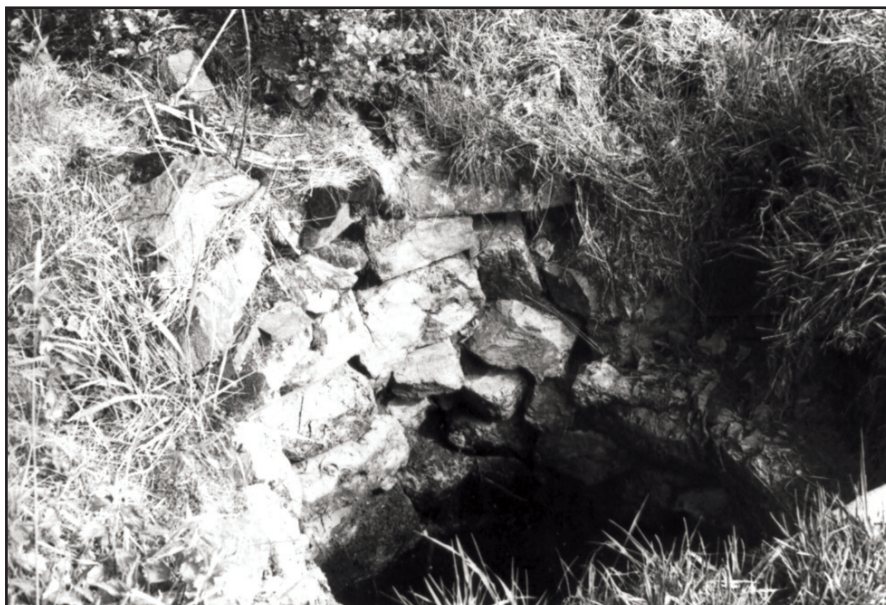
L'ancien puits de la Baraque Michel, aujourd'hui comblé. (Photo J.-M. Groulard, 1980).
