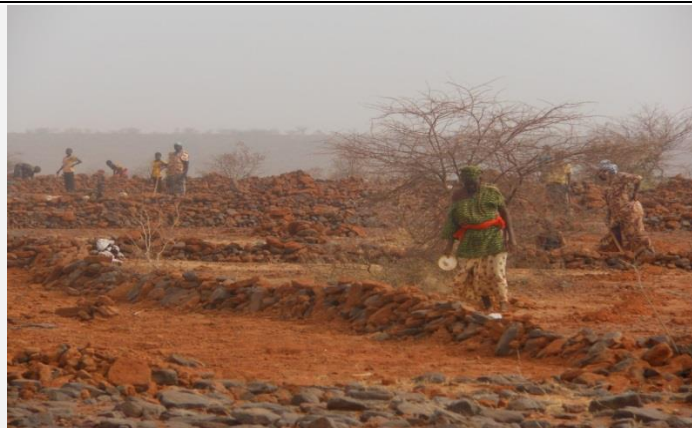
Photo 1 : Ouvrage de freinage du ruissellement des eaux de pluie sur plateau réalisé par les femmes Source : Enquête de terrain 2012
