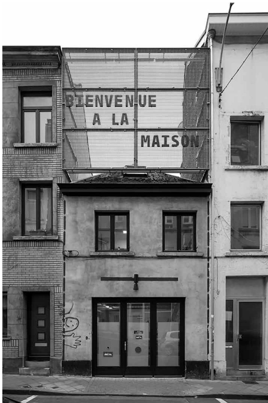
Fig. 4 Nouvelle façade du Théâtre le Rideau, institution occupant les bâtiments d'un ancien dépôt de charbon en coeur d'îlot – OUEST architecture – Rénovation et réorganisation d'une théâtre, Bruxelles (BE).
