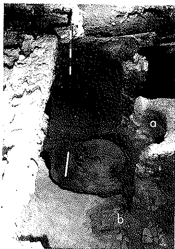
7. S. Maria di Vezzano L.: a destra le fornaci per campane con in centro quella di XIII sec.; a sinistra la sezione illustrativa della tecnica "Biringuccio 3" (a. fornacetta superiore; b. fornacetta inferiore).
