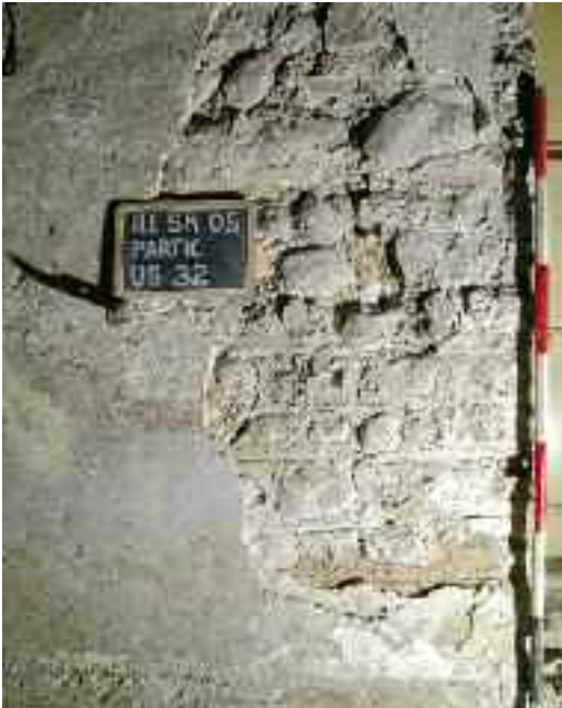
fig. 17. Muratura con tecnica a "stilature" della chiesa di fase IV. Particolare del muro sud.
