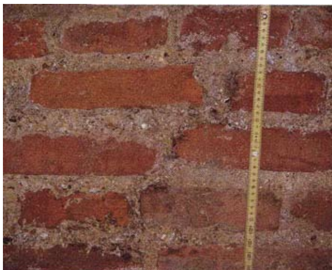
Fig. 13 – S. Lorenzo, tecnica costruttiva in laterizio del tetraconco (da Fieni 2004)
