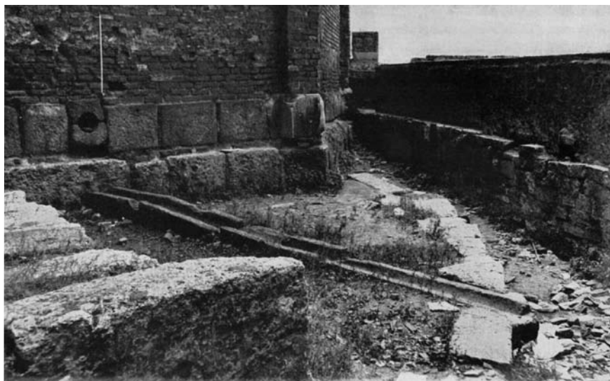
Fig. 7 – S. Aquilino (esterno), canale di smaltimento delle acque inglobato nelle fondazioni (da Ruffolo 1970)
