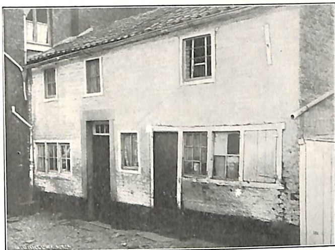
Rue Hoyoux (Cour Fontaine), n° 431 l .
