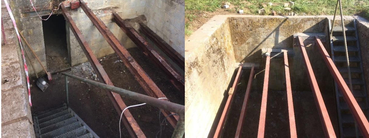
Figure 13. Restauration des poutres supportant les lysimètres.
