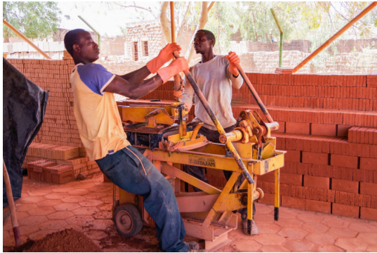
Fig. 4. — Fabrication de briques de terre comprimée à l'usine Zi-Matériaux à Ouagadougou (d'après l'auteur, 2017) – Presse à main de type TESTARAM.
