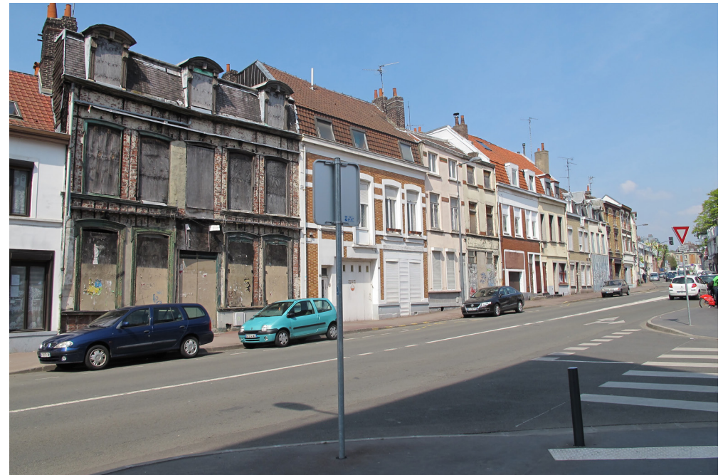
Dégradation d'un immeuble bâti inoccupé (Lille, 2013).
