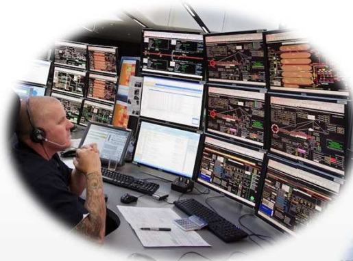
Centre de Commande Rio Tinto à Perth (AUS)
