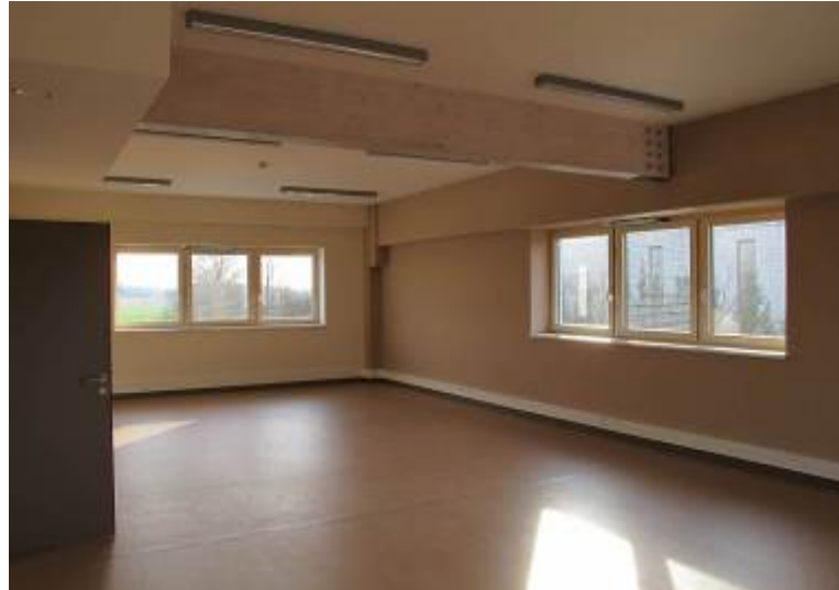
Figure 15 : Eclairage général des bureaux
