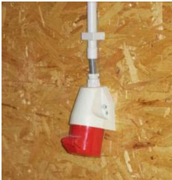
Figure 22 : Prise d'électricité haute tension dans les ateliers
