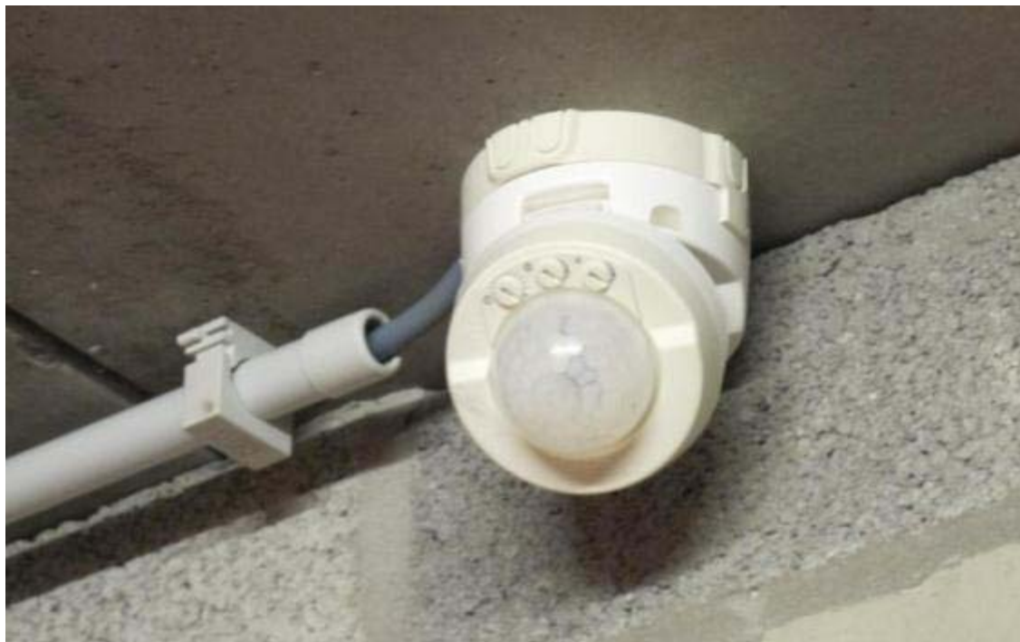
Figure 9 : Détection anti-intrusion
