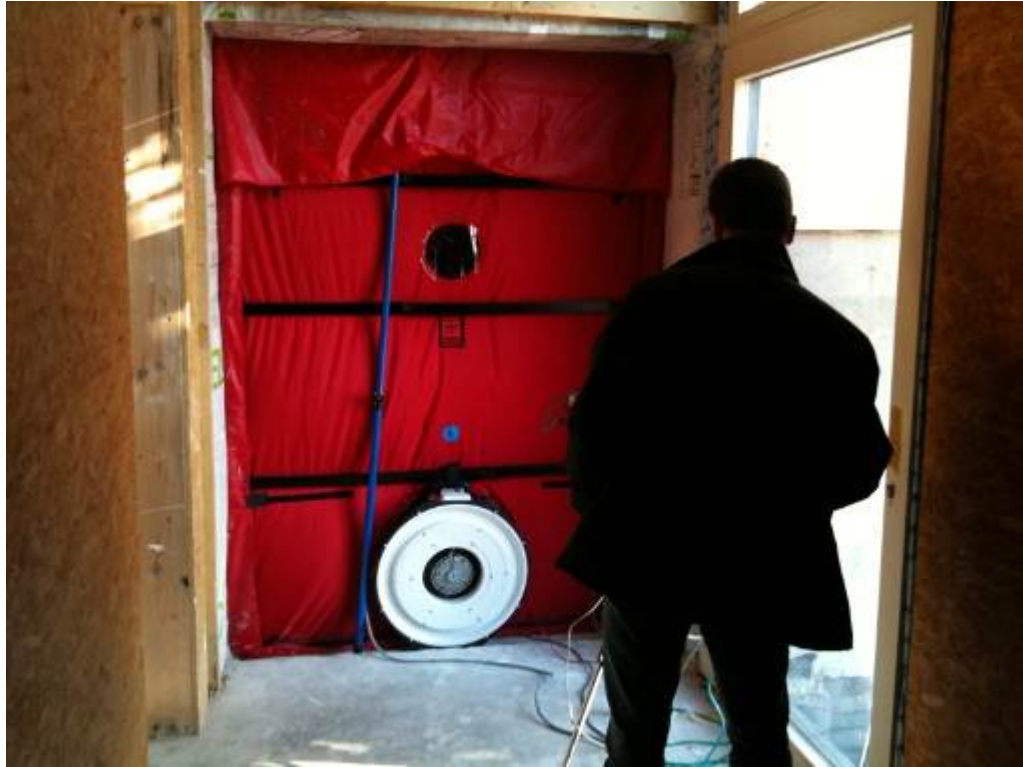
Figure 3 : Dispositif de l'essai de pressurisation
