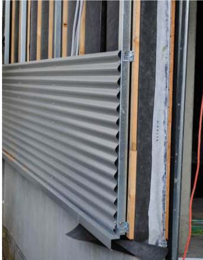
Figure 6 : Composition du mur extérieur des ateliers
