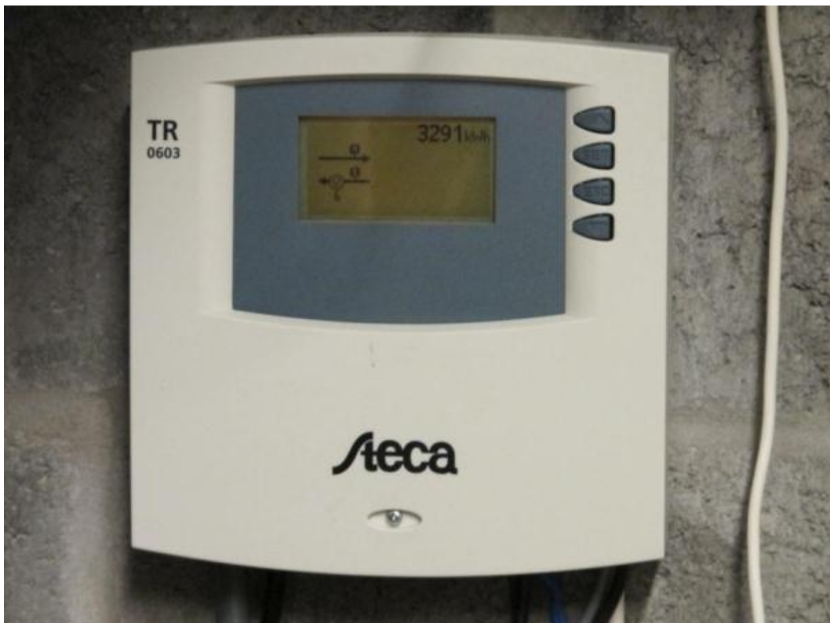
Figure 13 : Comptage de l'énergie apportée par les capteurs solaires thermiques
