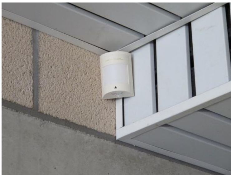
Figure 9 : Détection anti-intrusion (Pégase)
