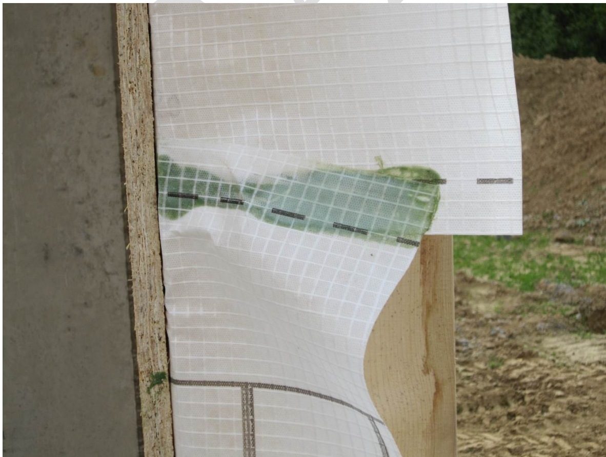
Figure 2. Détail de la pose du frein-vapeur
