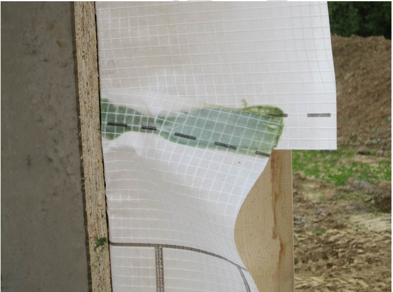
Figure 2. Détail de la pose du frein-vapeur
