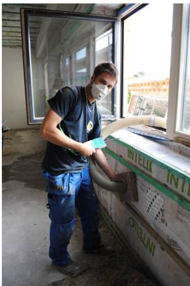
Figure 5 : Insufflation de l'isolation thermique dans les murs
