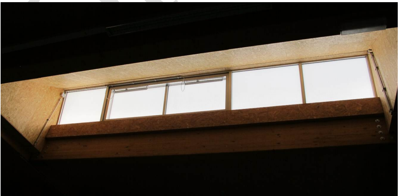
Figure 1. Lanterneau des ateliers vu de l'intérieur
