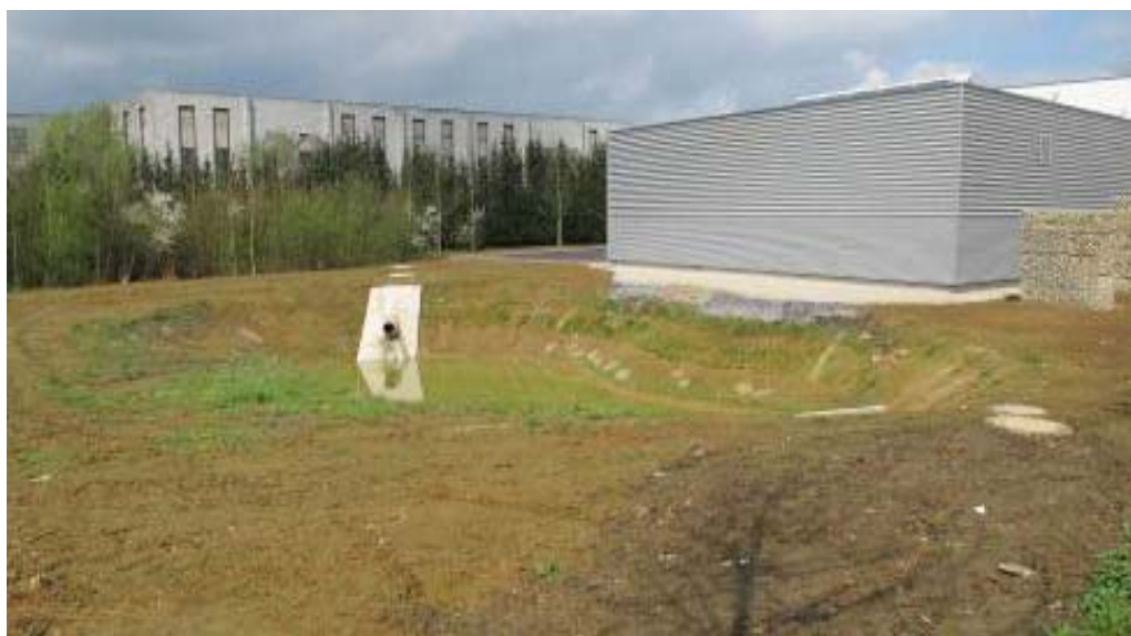
Figure 26 : Bassin de rétention des eaux
