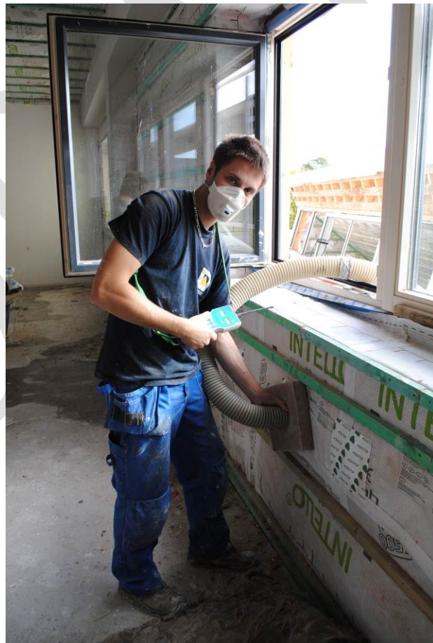
Figure 2: Insufflation de l'isolation thermique dans les murs
