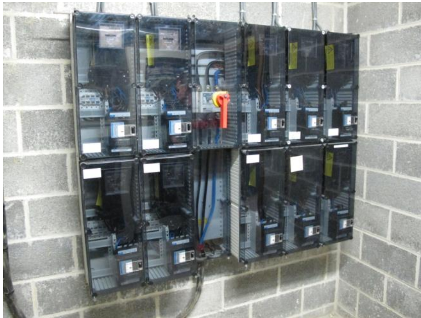
Figure 12 : Comptage individuel de la consommation électrique (Eridan)
