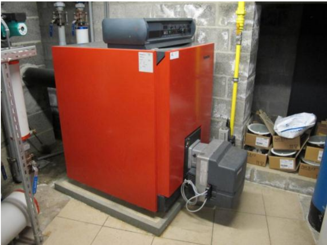
Figure 4 : Chaudière gaz à condensation
