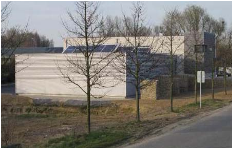
Figure 24 : Panneaux photovoltaïques en toiture des ateliers
