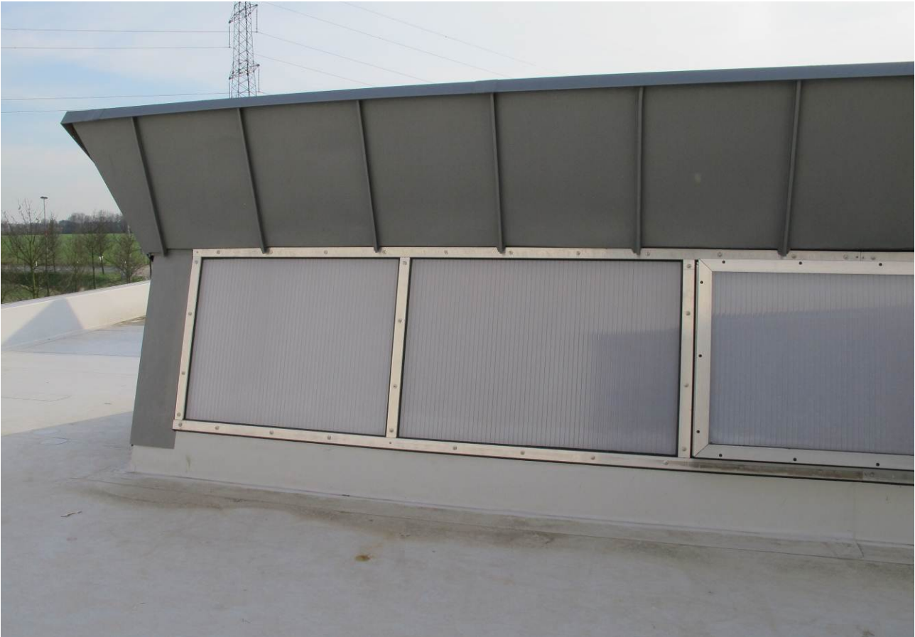
Figure 2. Lanterneau des ateliers vus de l'extérieur
