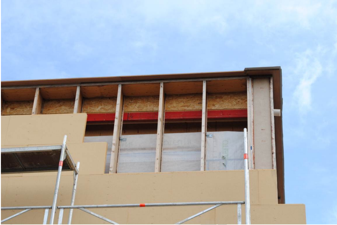
Figure 1: Photo du mur extérieur des bureaux avant que l'isolant ne soit insufflé
