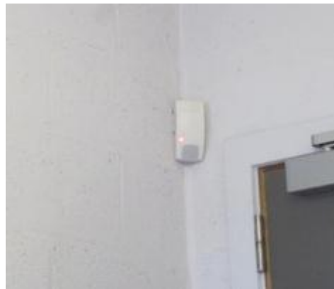
Figure 9 : Détection anti-intrusion
