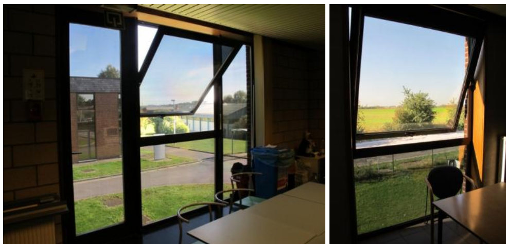
Figure 2 : Film appliqué sur les fenêtres bien exposées au soleil (Pégase, Eridan)
