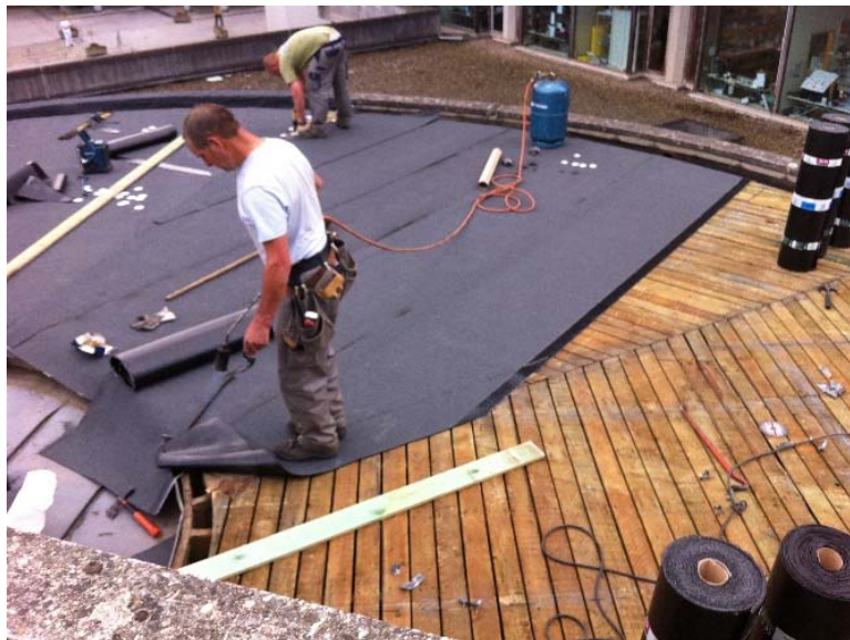
Figure 41 - Précédente rénovation de la toiture
