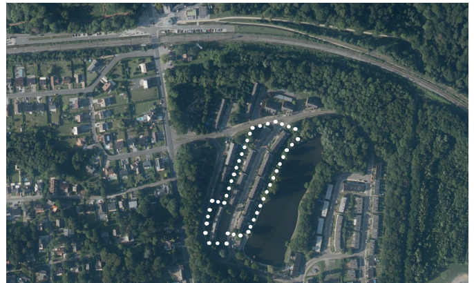
Situation : Le site se trouve à 1 km du centre ancien de Morlanwelz.
