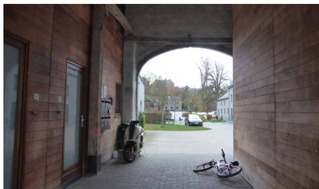
03. 10 appartements sont accessibles via l'ancien porche de la ferme.
