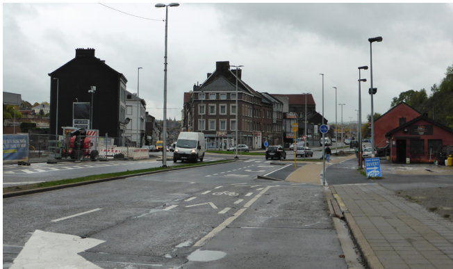
05. La RN627 est en train d'être réaménagée en boulevard urbain bordé par des pistes cyclables.
