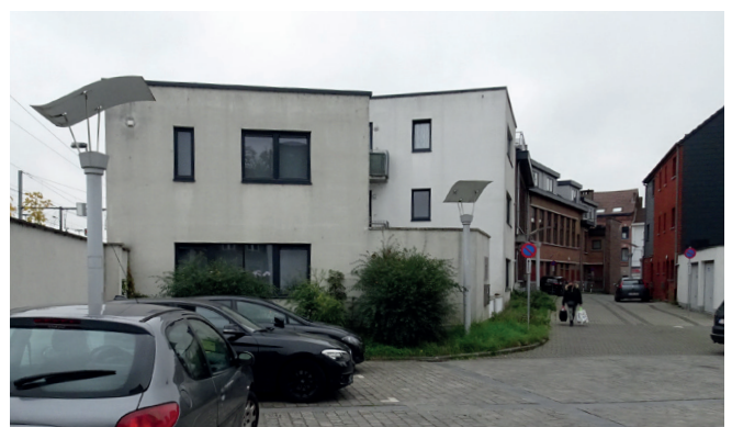
04. Construction d'un petit immeuble collectif de quatre logements
