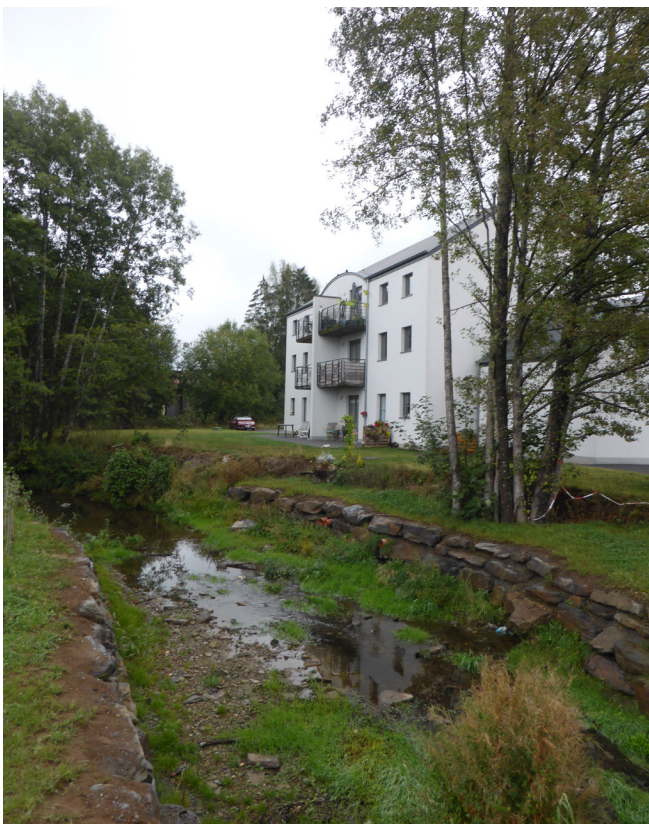
La Commune a réaménagé les berges du ruisseau et un pont pour augmenter la capacité de débit et limiter le risque d'inondation.
