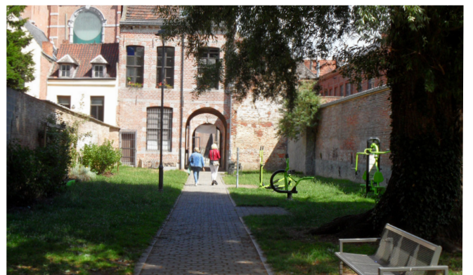
04. Le jardin Gustave Jacobs permet d'accéder à la rue d'Havré à travers un ancien hôtel de maître rénové.
