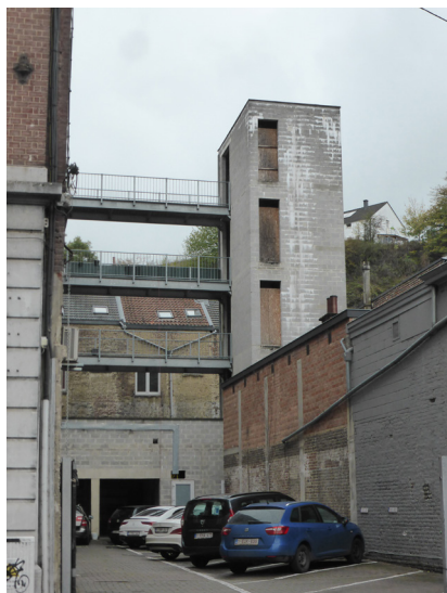
02. Une tour d'accès non finalisée dessert les logements.
