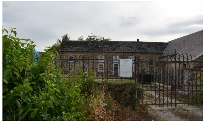
03 et 05. Corps de ferme et grange en cours de réaffectation en un gîte 4 ch. (en face) et des appartements 1 ch. (à droite).
