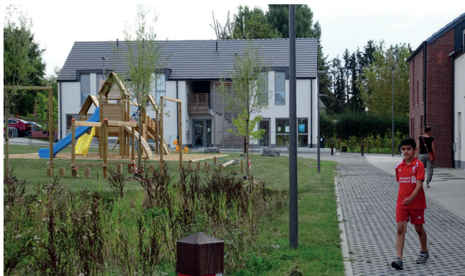
05. Immeuble mixte (commerce, services et logements).
