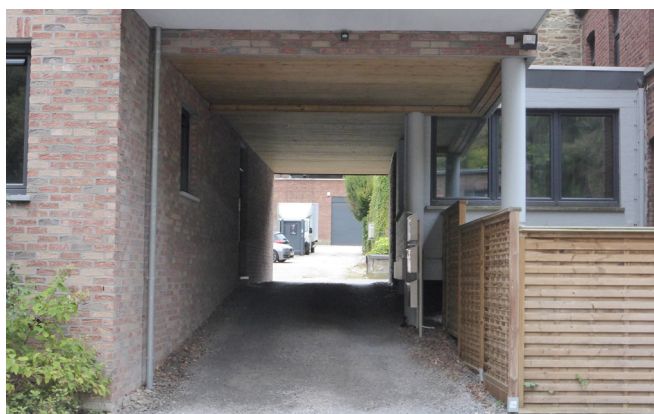
03. L'accès entre la rue et la cour intérieure qui sert principalement d'espace de stationnement.
