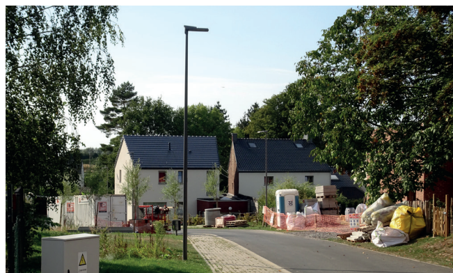
08. Intégration au bâti existant
