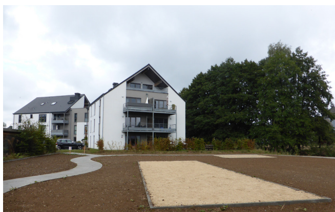
05. L'espace vert public est localisé en intérieur d'îlot le long de la rivière et a été rétrocédée à la commune de Léglise par Habitat+.
