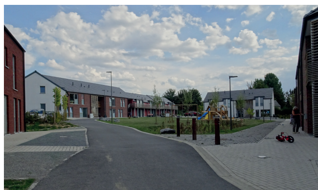
04. Gauche : Appartements gérés par la SLSP et le CPAS. Droite : Immeuble mixte (commerce, services et logements).
