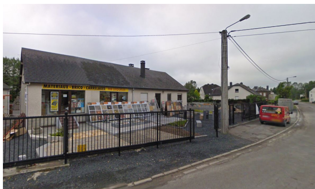
Situation initiale : L'entreprise de construction, en cœur de village
