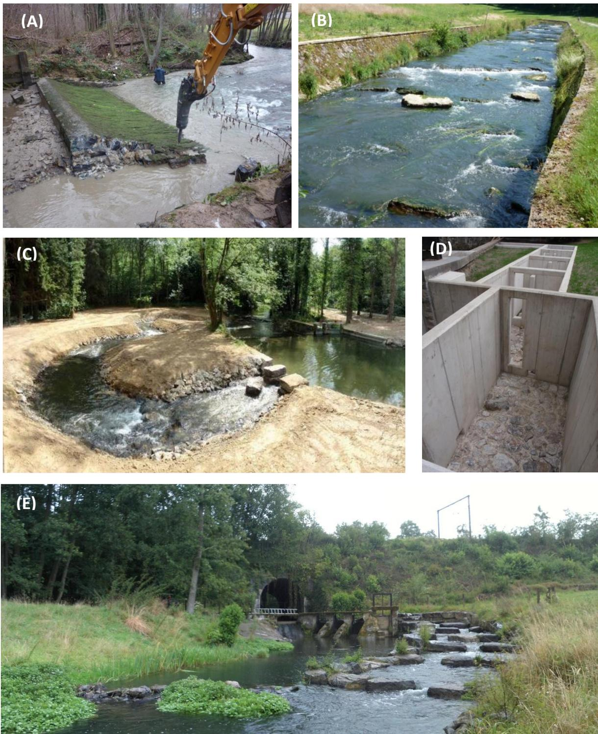
Figure 2.19 : Exemples de levées d'obstacle sur le Bocq : (A) arasement d'un déversoir à Spontin, (B) aménagement d'une rampe rugueuse à Spontin (zone de captages Vivaqua), (C) aménagement d'une rivière de contournement à Purnode, (D) construction d'une passe à bassins technique à Yvoir, (E) aménagement d'un dispositif combinant des pré-barrages avec une rivière de contournement à Braibant.
