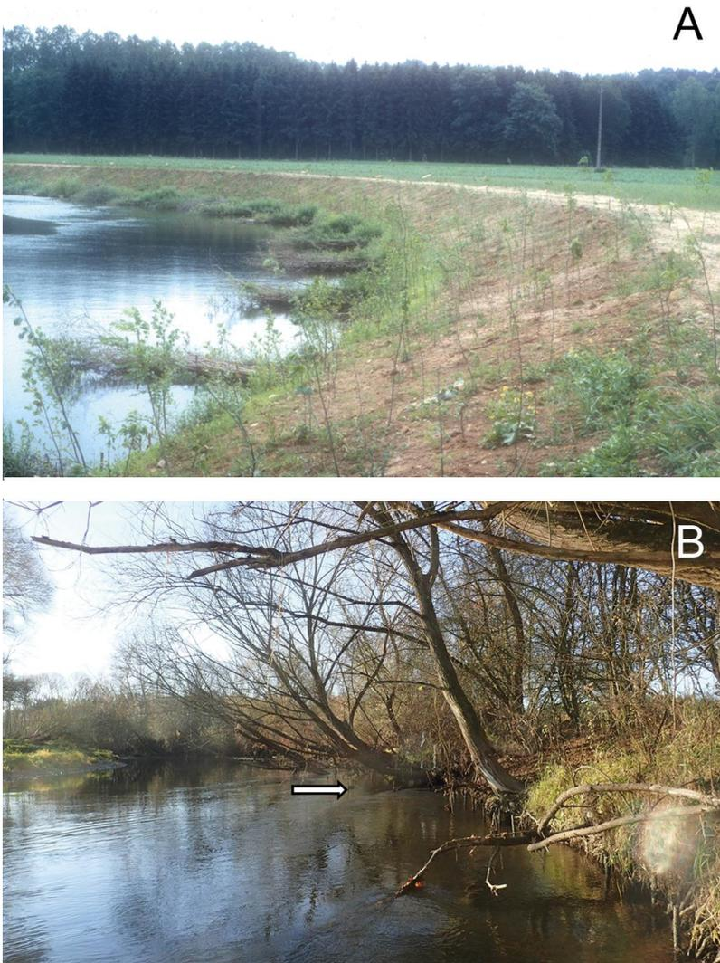
Figure 5.10 : Epis composés de branchages sur la Lesse à Villers-sur-Lesse (ID-15). Vue vers l'amont. (A) Pendant leur mise en place en 1996 ; (B) 20 ans après leur mise en place. La flèche blanche montre l'extension d'un des épis détruits.
