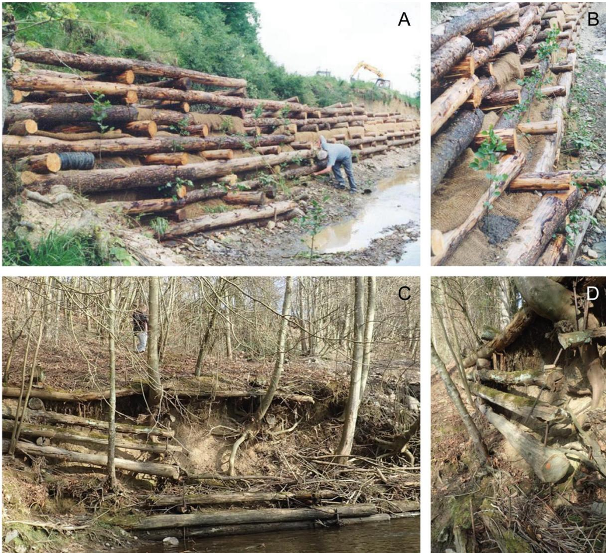
Figure 5.8 : Caisson sur l'Eau Noire à Petigny (ID-10). (A) Pendant sa mise en place en 1996 (photo L.-M. Petiau) ; (B) Plantation d'aulnes sur le caisson (photo L.-M. Petiau) ; (C) Caisson détruit 20 ans après son installation ; (D) Détail des rondins endommagés.
