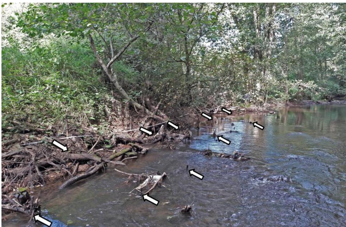
Figure 5.6 : Aisne à Juzaine (ID-2b) : peigne détruit 15 ans après sa mise en place et berge en cours d'érosion. Vue vers l'amont. Les flèches blanches montrent les piquets métalliques de l'ancien peigne.
