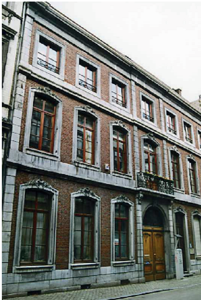
Fig. 1.13. L'ancien hôtel de Laminne, rue des Augustins à Liège, 2004 (©Inventaire du Patrimoine Immobilier de Wallonie).
