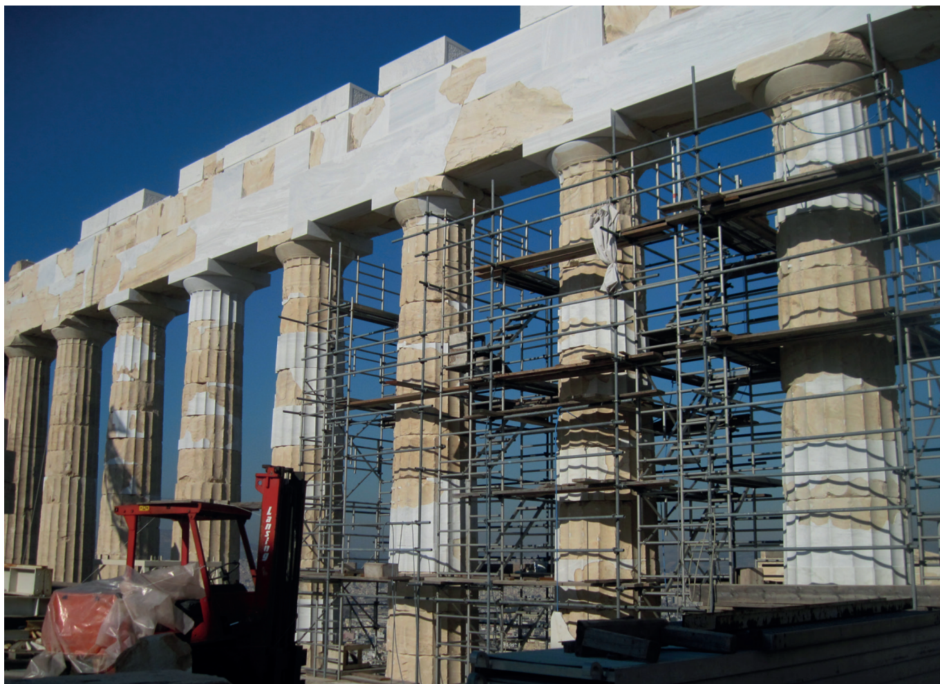
Fig. 1.7. Le chantier de restauration du Parthénon en cours, 2012 (©International Institute for Restoration and Preservation Studies).
