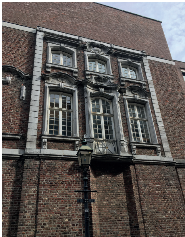
Fig. 1.14. Vestiges d'une façade du XVIII e siècle intégrée dans une façade contemporaine, Kockerellstrasse, Aachen, 2019 (©Nicolas Sougnez).
