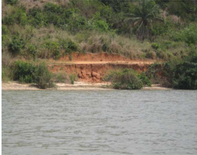
FIGURE 5.2 – Erosion avancée des berges du lac Ahémé à Houédjro, rive Atlantique, obstruant presque la piste déserte longeant le plan d'eau [66].
