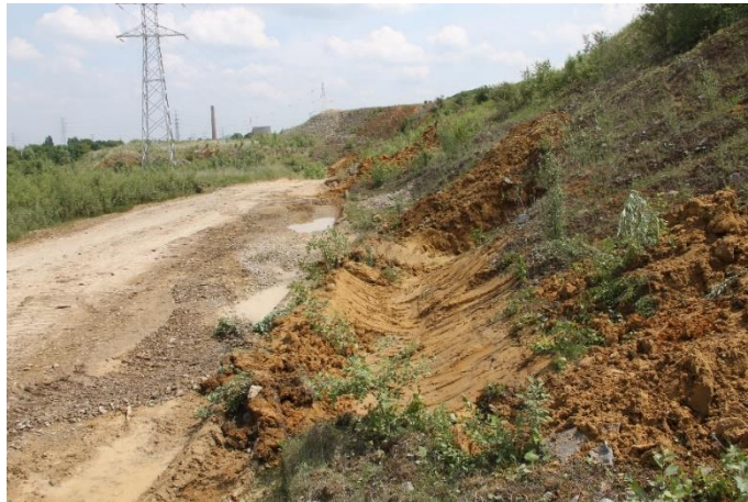
Figure 7. Canalisation des eaux de la piste (Création : 26/05/2016).
