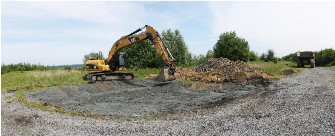
Figure 5. Placage d'argile sur une mare afin d'en assurer l'imperméabilisation (Création : 10/06/2016).
