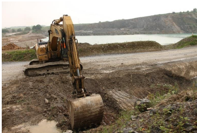
Figure 12. Curage d'un fossé colmaté (Création : 08/06/2016).
