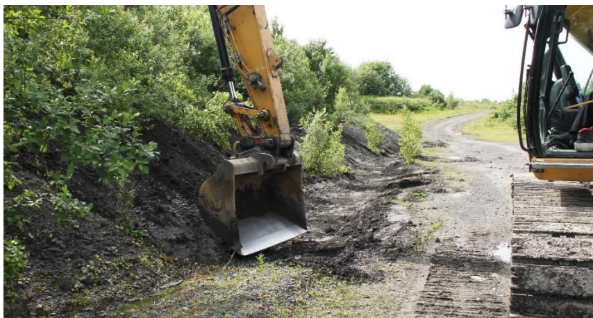
Figure 6. Canalisation des eaux de la piste (Création : 10/06/2016).
