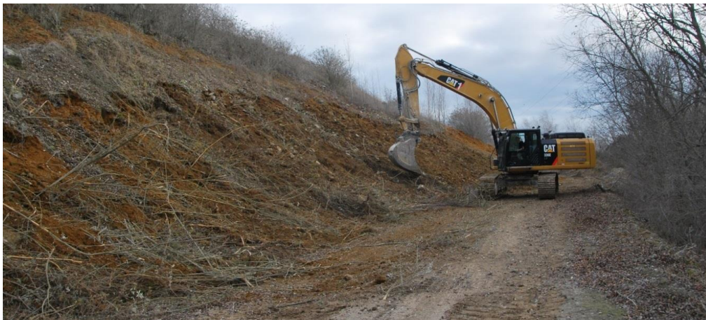
Figure 43. Rafraîchissement des pentes d'une motte (Création : 09/12/2016).
