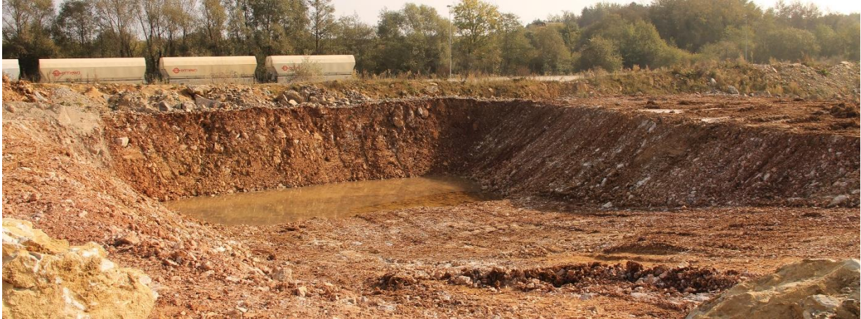
Figure 31. Mare permanente créée dans le substrat meuble et alimentée par la nappe du bassin (19/10/2018).
