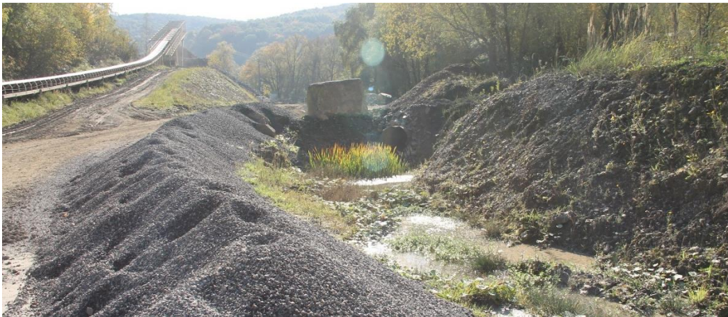
Figure 1. Cordon de gravier mis en place afin de protéger un fossé d'intérêt identifié lors des inventaires (16/10/2017).
