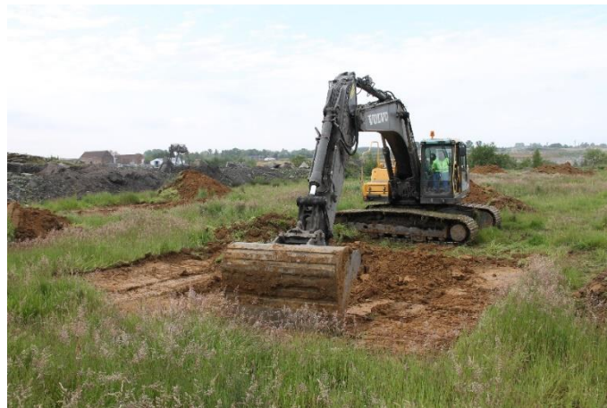
Figure 3. Creusement d'une mare sur limon argileux (Création : 25/05/2016).
