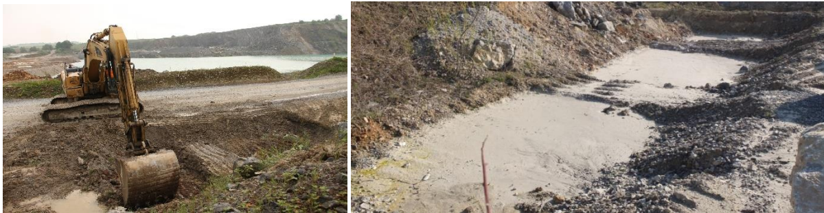
Figure 18. Sédimentation d'un fossé (Type 1.2), 9 mois après le dernier curage (08/06/2016 à gauche, 27/03/2017 à droite).
