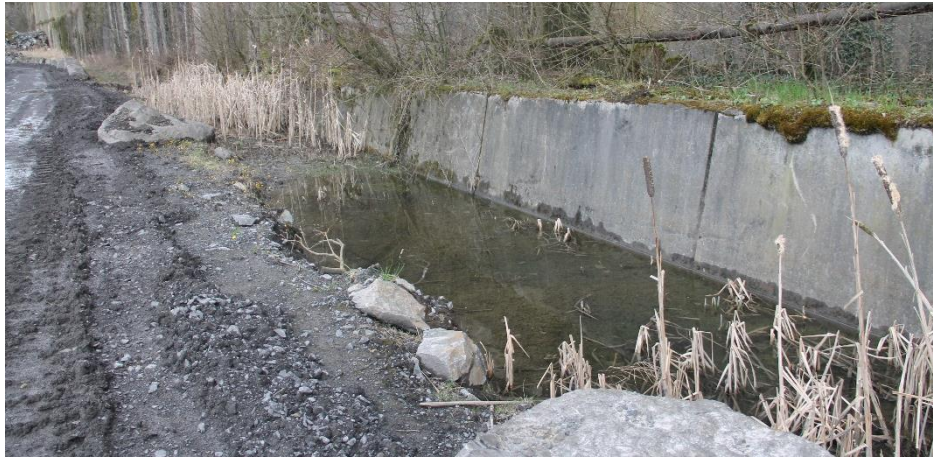
Figure 11. Fossé creusé en pied de falaise (Création : 25/05/2016).
