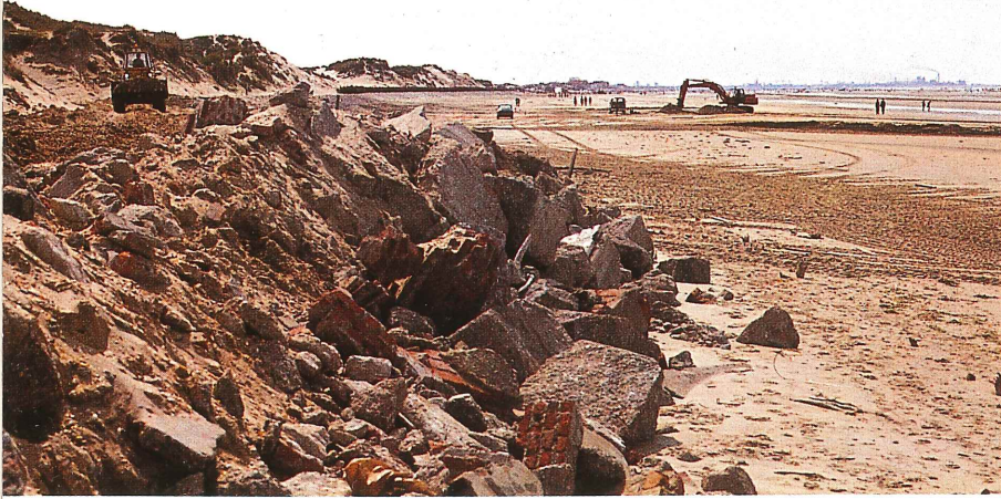
La Panne-Westhoek (1978): Construction d'une digue longitudinale comme défense du pied de dune, et de brise-lames transversaux pour stabiliser le transport longitudinal par la dérive côtière (G.D.M.).
