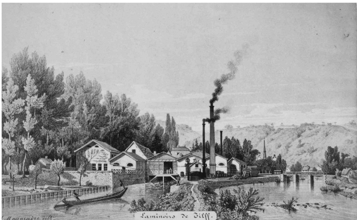
Gravure de Maugendre (vers 1860-1865) reprenant la mise en scène de celle de 1850 mais présentant les importantes transformations réalisées au cours des années précédentes. Notez que le site compte à ce moment deux nouvelles cheminées, mais que la cheminée des fours à refondre a disparu depuis 1852. La maison de maître a été remplacée par un bâtiment plus fonctionnel et trois halls de stockage. Le pont hollandais est toujours présent.
