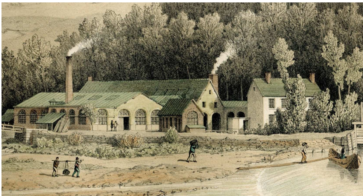
« Vue des usines prise du déversoir ». Extrait d'une gravure de Maugendre (1855) montrant les installations du laminoir avec ses deux cheminées. Remarquez la bêtchète à l'entrée amont du bief et la maison du directeur.
