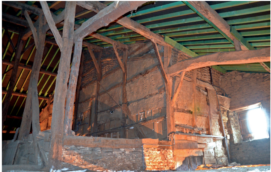
Fig. 2.- Parçon délimitant le logis, vue de l'intérieur, depuis le nord-ouest. © Patrick Hoffsummer (ULg-CEA 2013).
