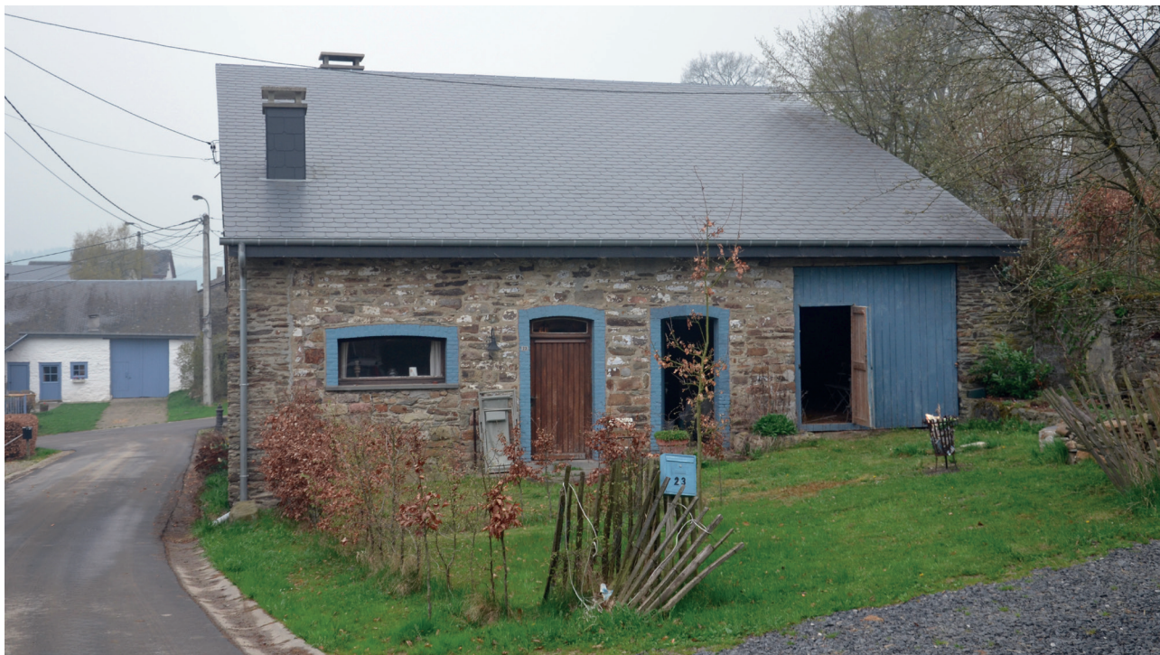
Fig. 1.- Ferme de Hierlot : mur gouttereau oriental.
