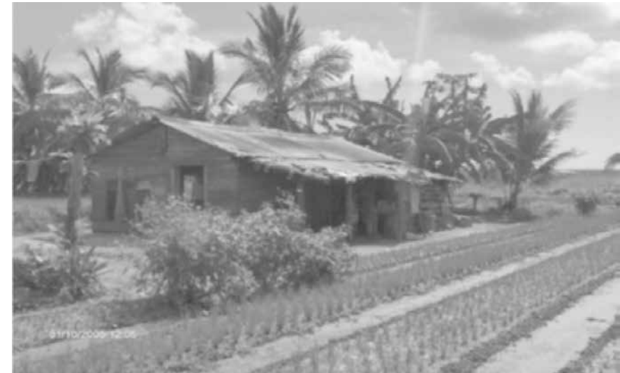
Ilustración 17. Imagen de la vivienda mínima inestable intermedia
